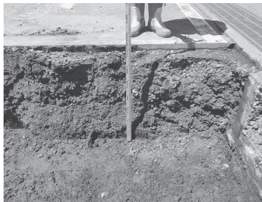
写真 2 断面確認状況
