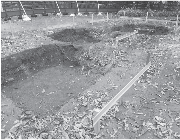
写真1 掘削後の様子
