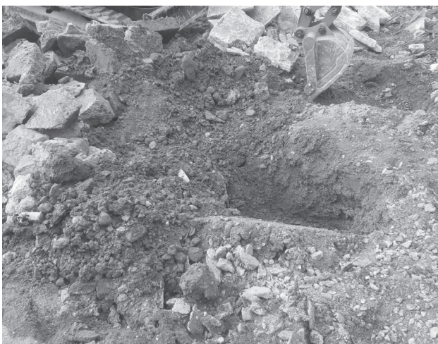
写真5 最大掘削深度
