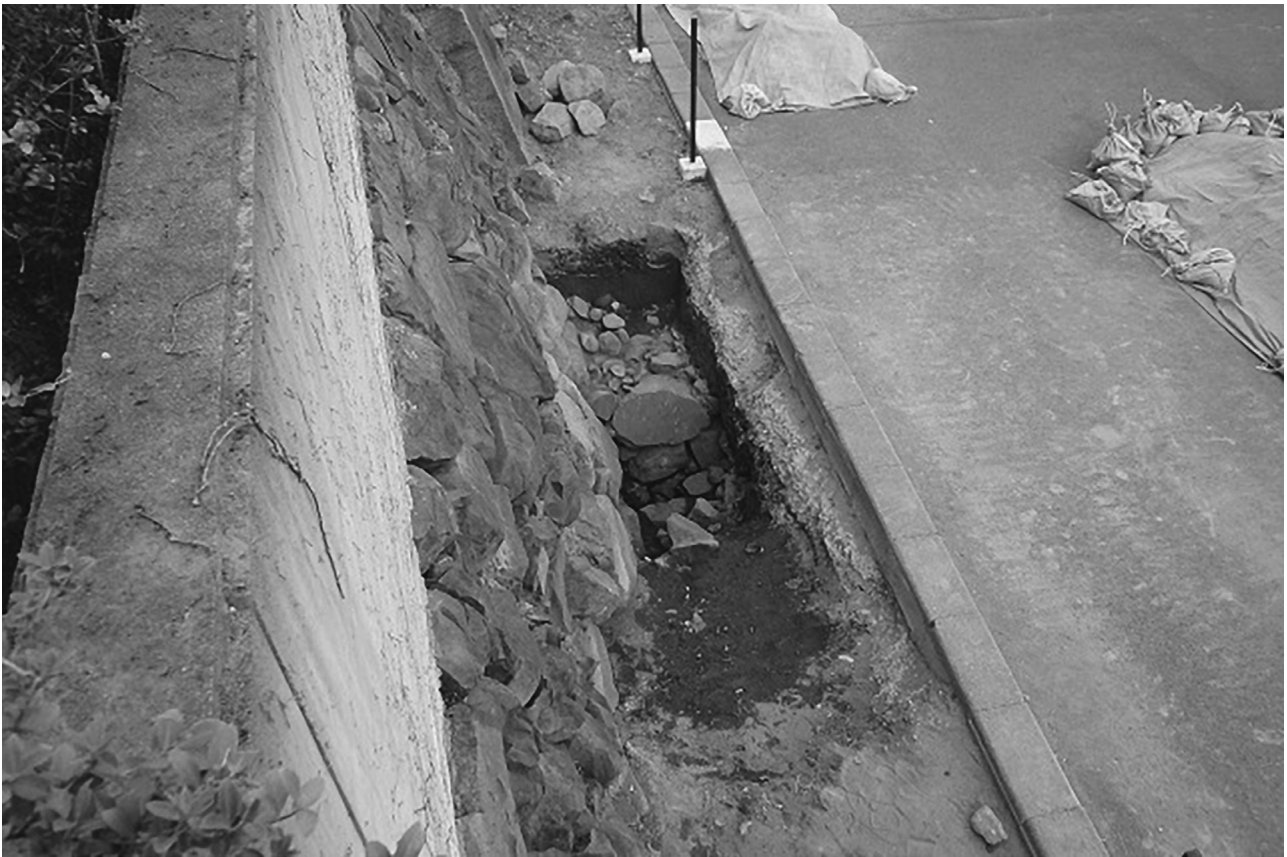
10号トレンチ完掘状況（南から）
