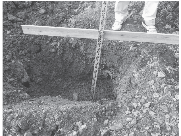
写真4 掘削後の様子
