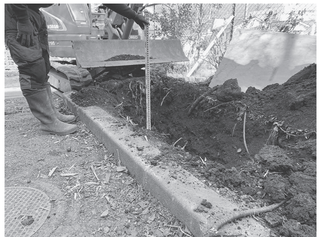
写真4 第2号トレンチ最大掘削深度
