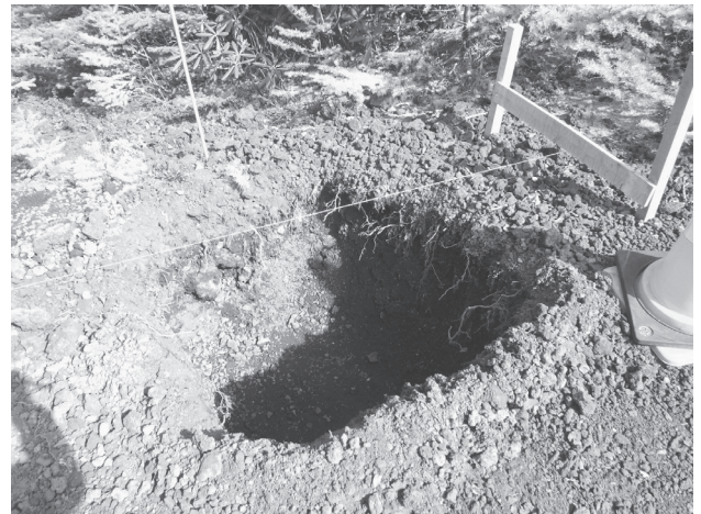
写真2 掘削後の様子
