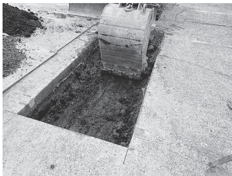
重機による掘削
