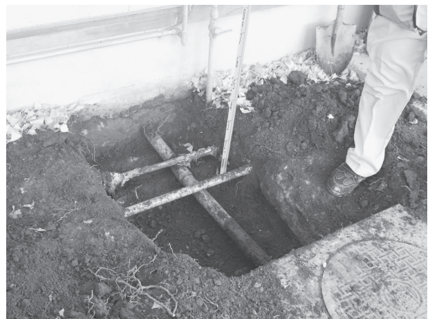
写真 2 掘削状況（東から）
