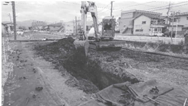
写真8 重機による埋め戻し作業 (T14)
