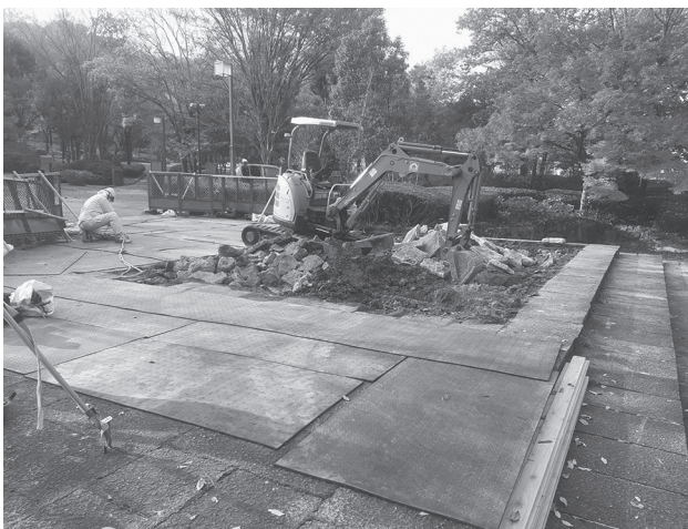
写真3 石敷撤去の様子
