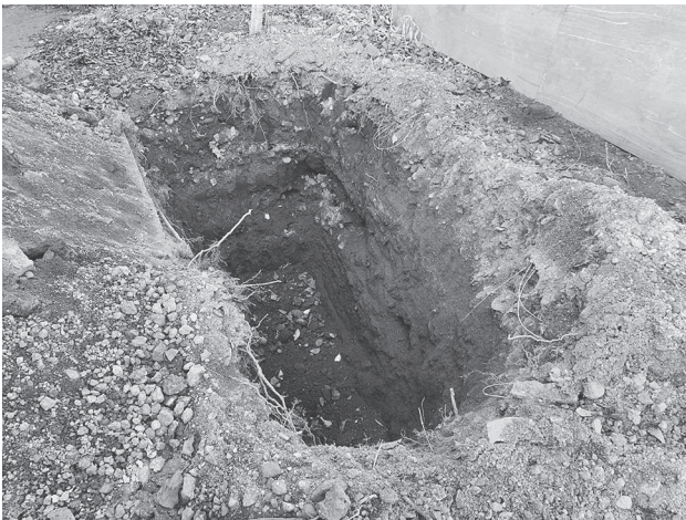
写真1 第1号トレンチ掘削後の様子
