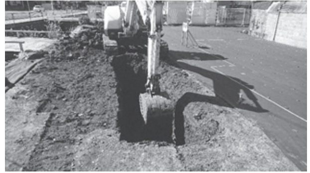
写真7 重機による掘削作業 (T3)
