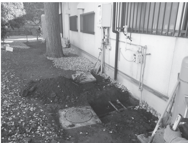
写真 1 掘削状況（西から）
