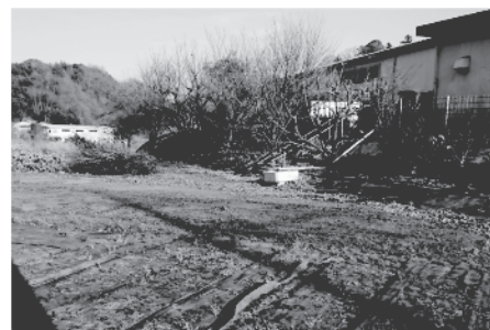
写真 2 埋め戻しの様子
