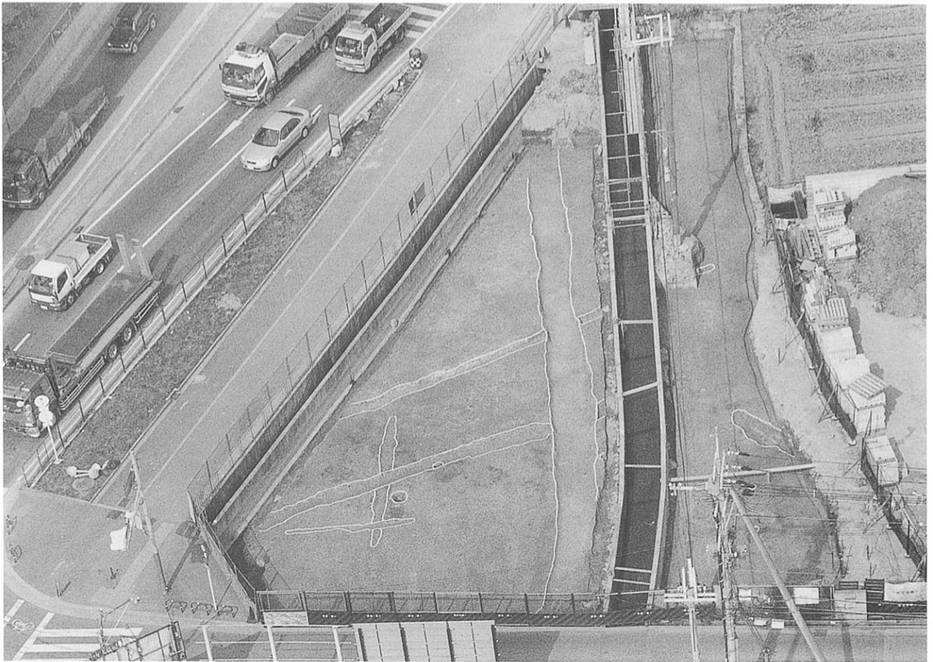
2. 1R・1Sトレンチ全景 (南から)
