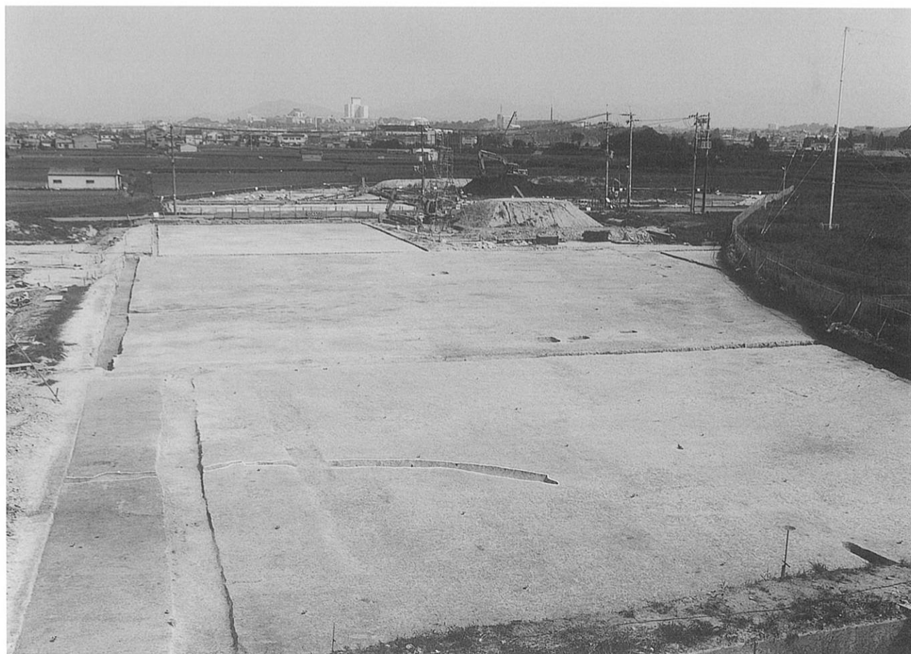
2. 同上（北西から）
