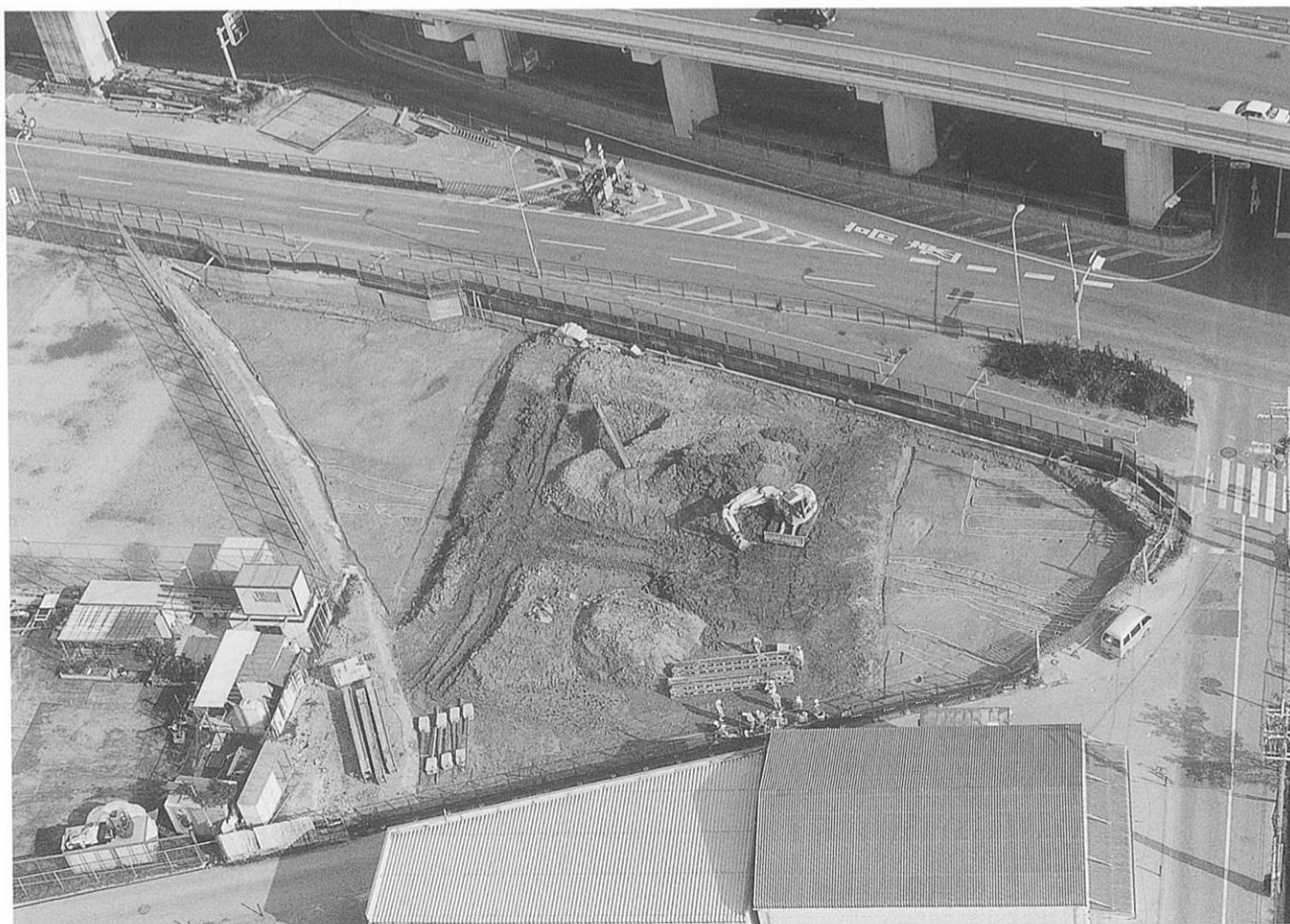
2. 2Qトレンチ北・南部 全景（西から）
