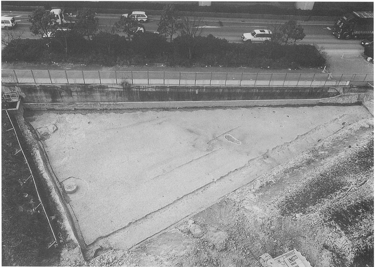
2. 8Eトレンチ全景 (南東から)
