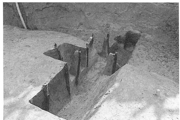
第9面川68杭群掘削状況 (北から)
