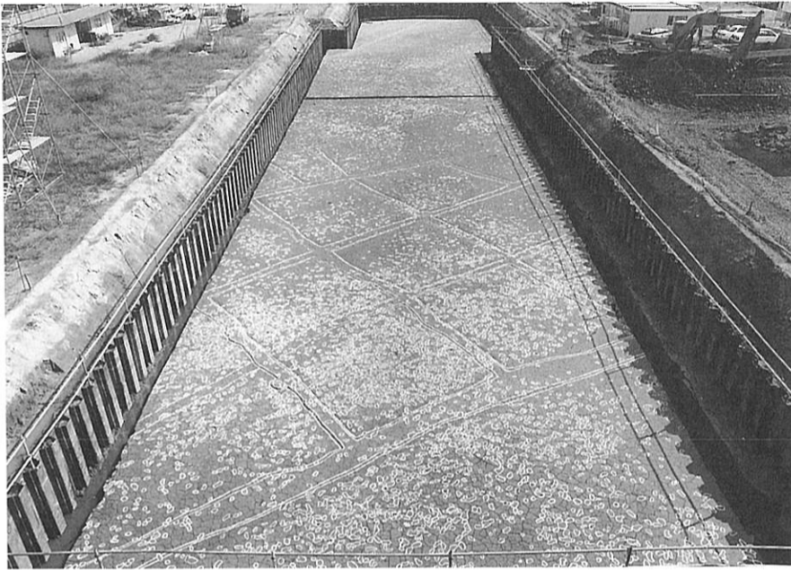
(1) 3 A区第7面 (西から)
