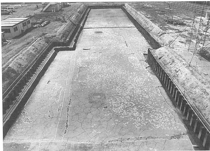
(1) 3 A区第2面 (西から)
