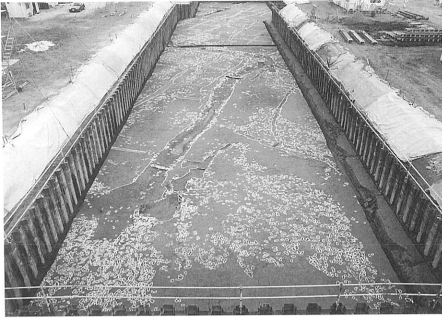
(1) 3 A区第11面 (西から)
