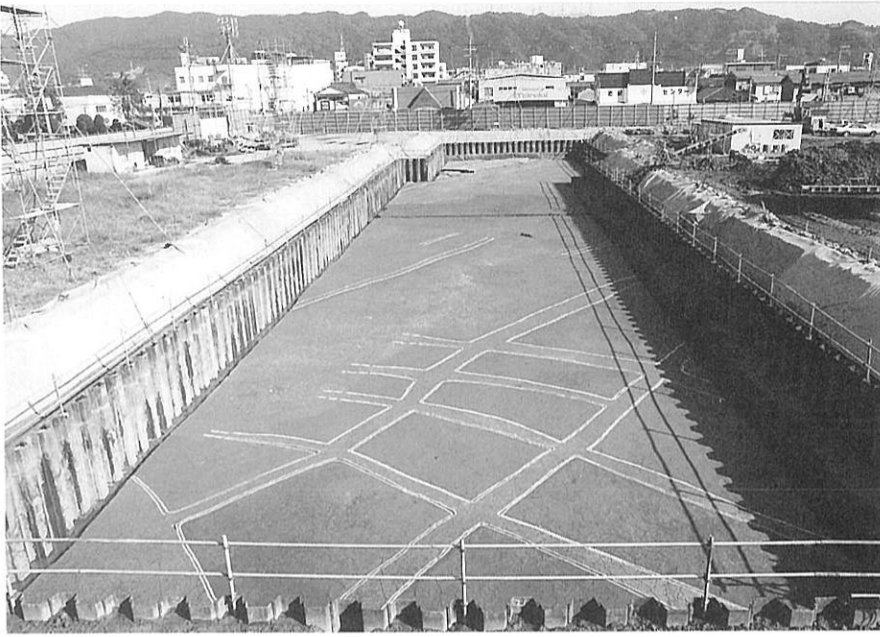
(1) 3 A区第9面 (西から)
