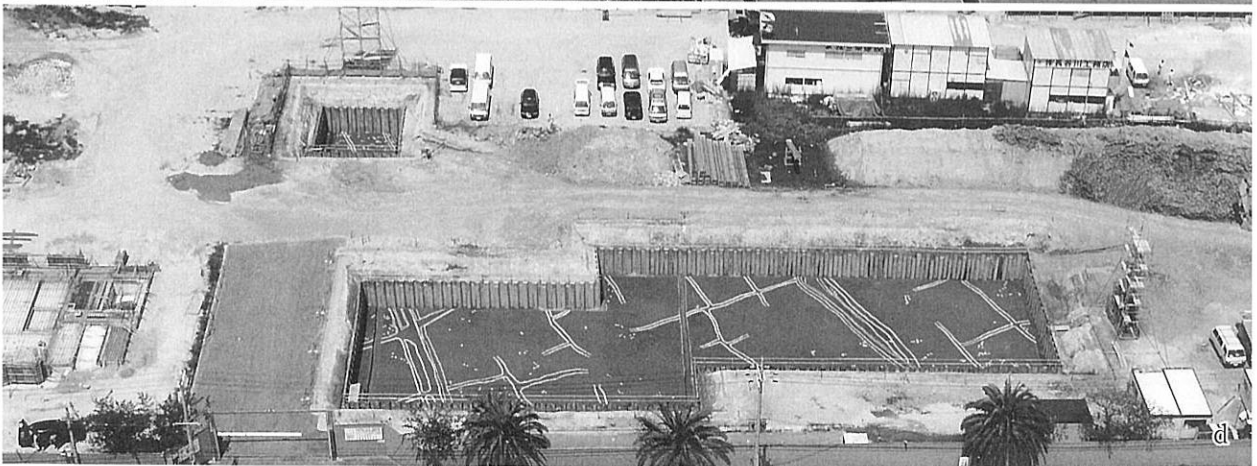
a. 第1遺構面(南から) b. 第2遺構面(南から) c. 第3遺構面(南から) d. 第4遺構面(南から)
