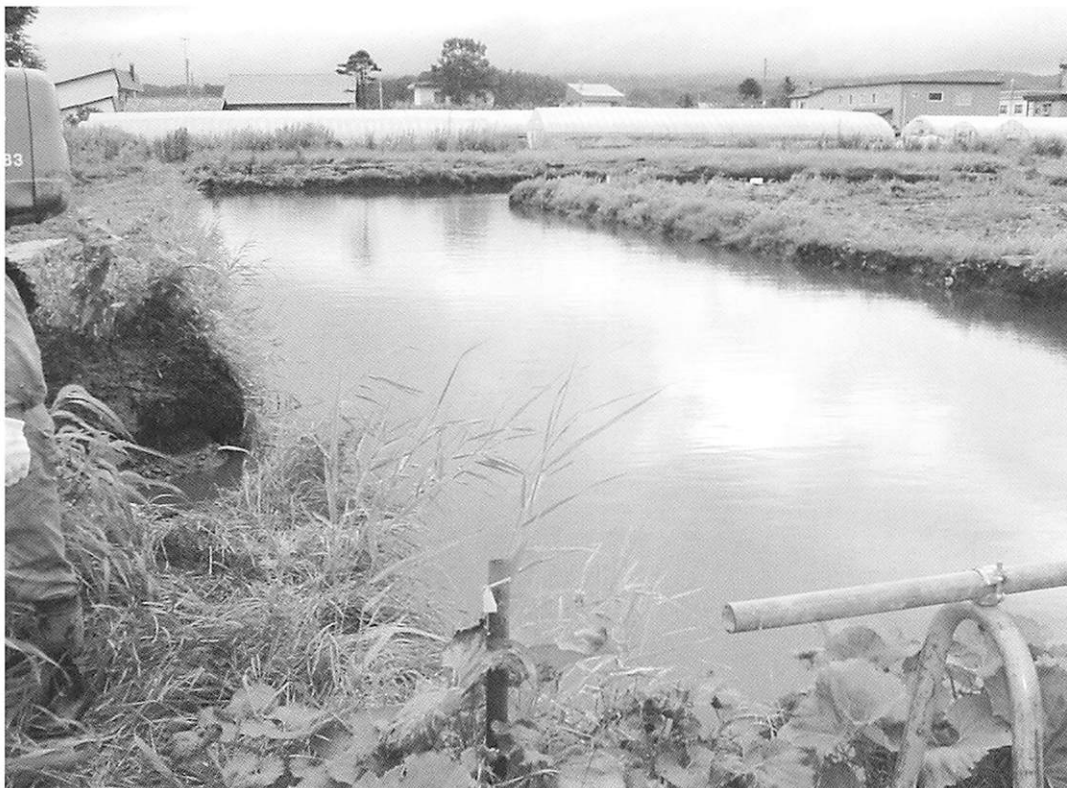
低湿地の浸水状況（北西方向より）
