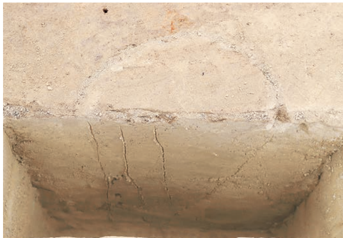
SA225-P2 断面(東から)
