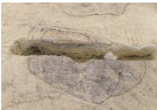
SX23 断面(北から)
