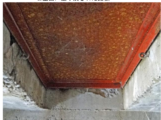
図40. 同上・監的鏡用開口部の鉄ピン(S→N) 同上 * 上蓋の鉄製屋根は近年の整備
