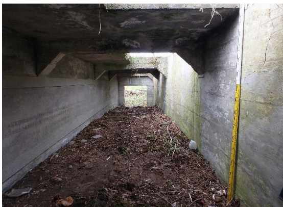
図 24. 同上・内部 (S→N) 同上 * 左壁面に寄付者銘板
