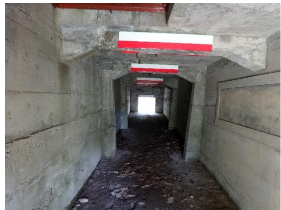
図39. 同上・内部と柱状のバットレス(W→E) 同上 * 右壁面に塗り潰された銘板
