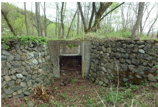
図 23. 同上・北側出入口と練積み擁壁 (N→S) 同上
