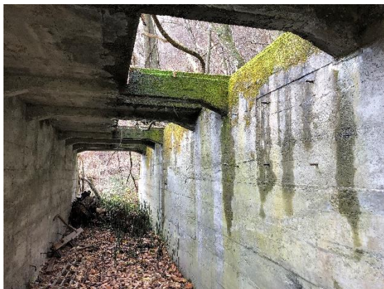
図11. 同上の壕内 (N→S) 同上 * 右壁面の上部に支柱用のボルト
