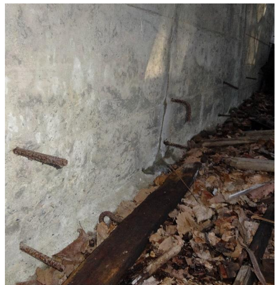
図13. 同上・東側壁面の植え込みボルト (NW→SE) 同上
