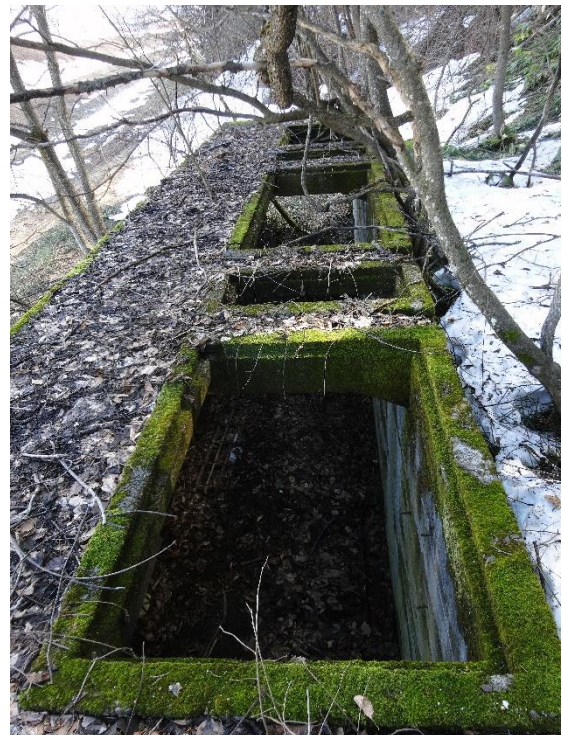
図12. 富良野町分会監視壕の掩蓋開口部 (N→S) 2020. 4. 5
