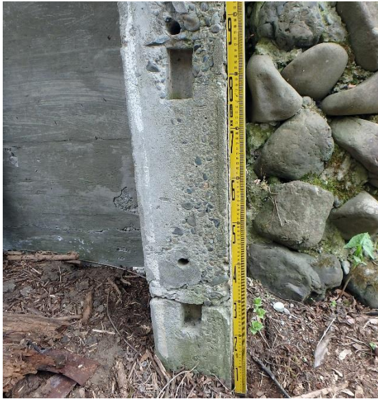
図 28. 山部村分会監的壕の扉金具類の埋め込み跡 (E→W) 2020. 5. 16
