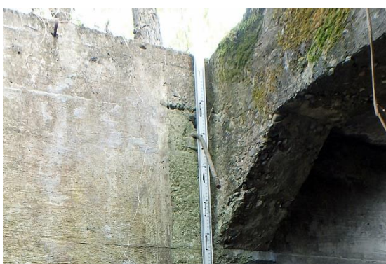
図 27. 同上・用的開口部東壁のボルト (NW→SE) 同上 * ボルトは折れ曲がった状態
