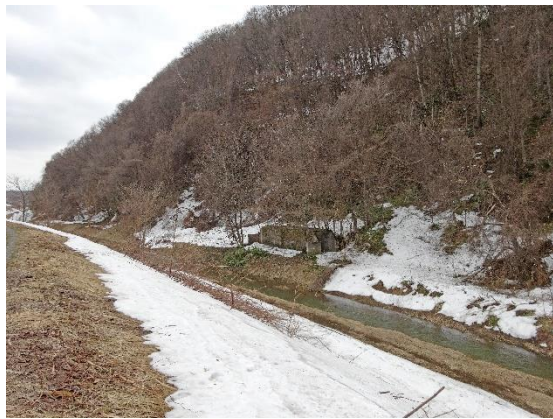
図9. 富良野町分会監視壕の遠景 (N→S) 2021. 4. 3
