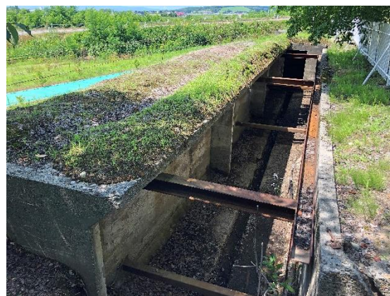
図54. 一已村分会小銃射撃場監的壕(深川市市指定文化財「監的壕」) 掩蓋形状から、回転式と推定される。排水溝は中央に位置する。内部のH鋼は近年の補強。
