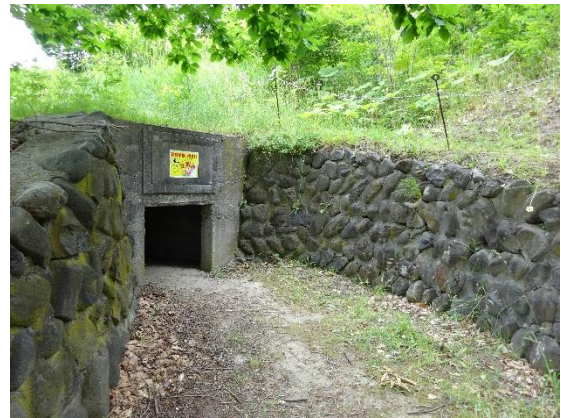
図38. 上富良野村分会監的壕の東側出入口と練積み擁壁(SE→NW) 同上
