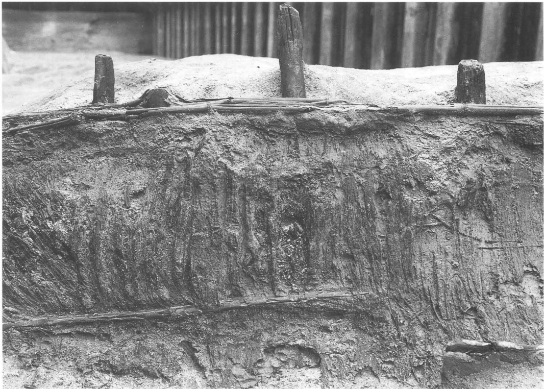
2. 堤防東面杭列、葦
