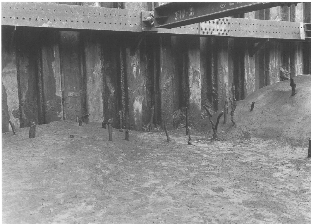
1. 落ち込み内杭列
