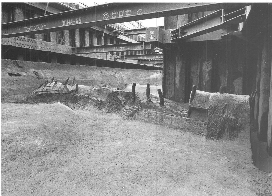
2. 堤防東面杭列、葦、前面杭列
