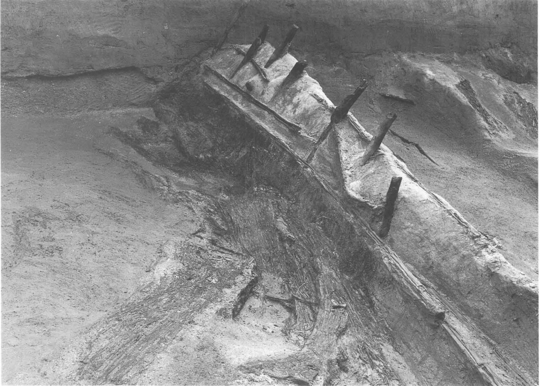
1. 堤防東面杭列、葦
