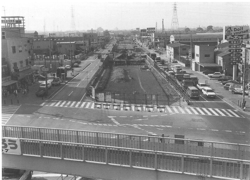
1. トレンチ全景(東より)
