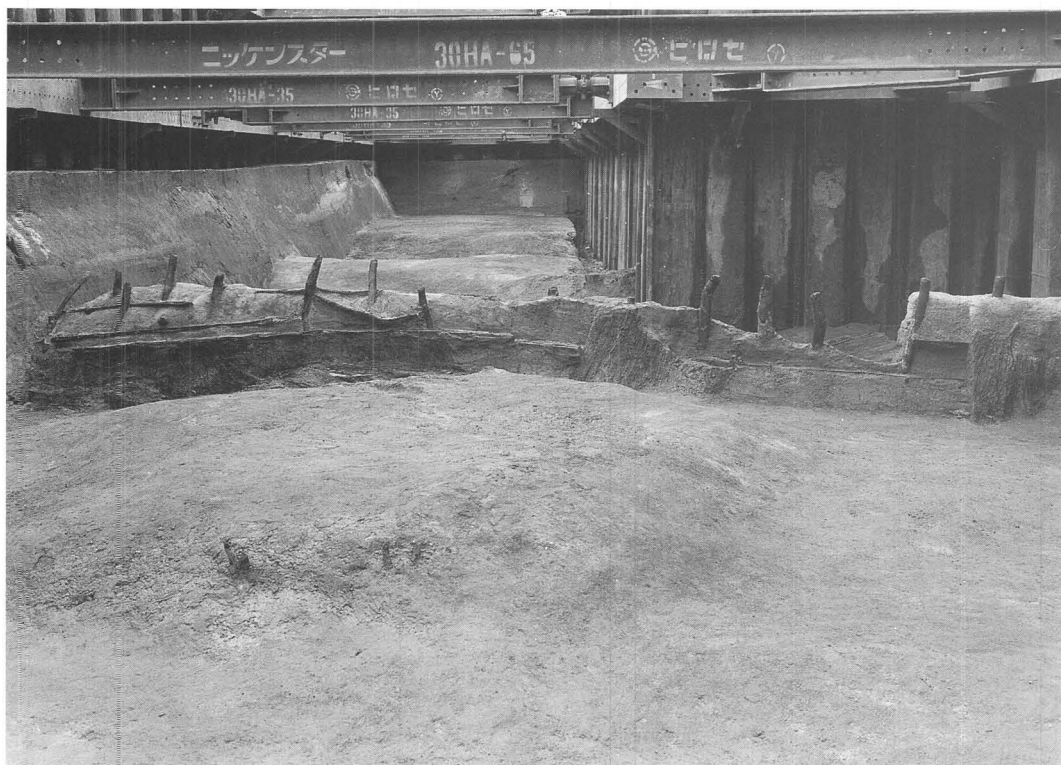
1. 堤防東面杭列、葦、前面杭列
