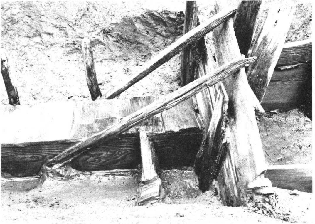
1. 溝9堰・暗渠水路
