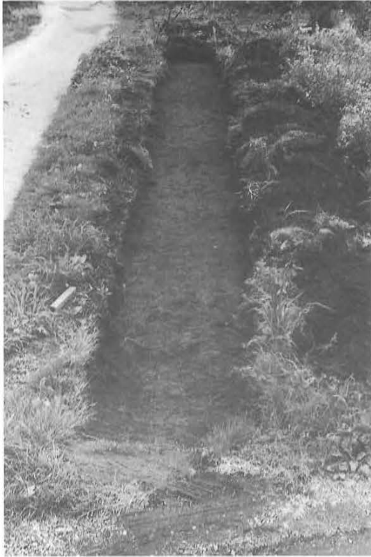
⑥区掘削状況（東より）
