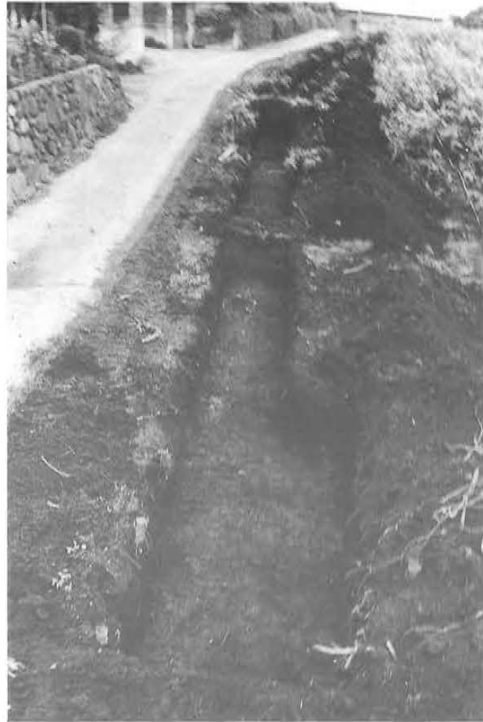
②区、③区掘削状況（西より）
