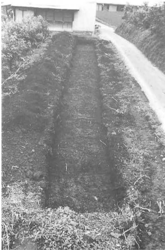
④区掘削状況（東より）
