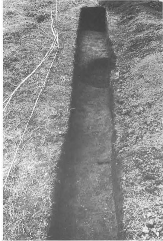
⑦区掘削状況（東より）
