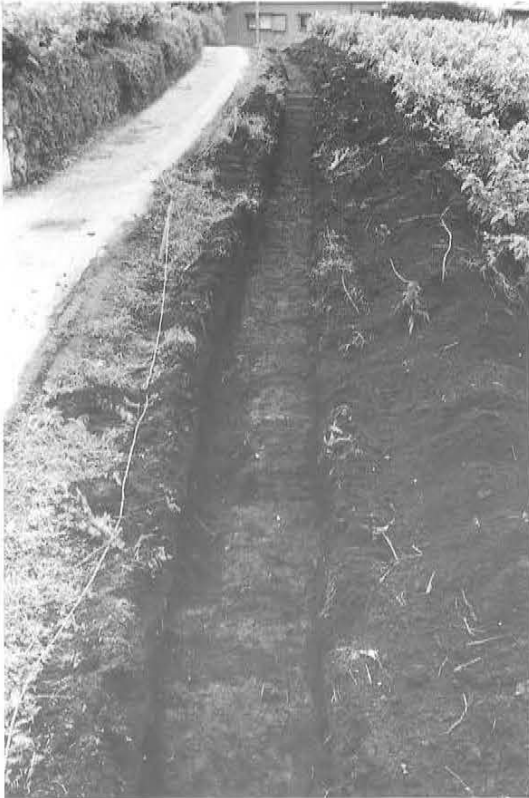
①区掘削状況（西より）
