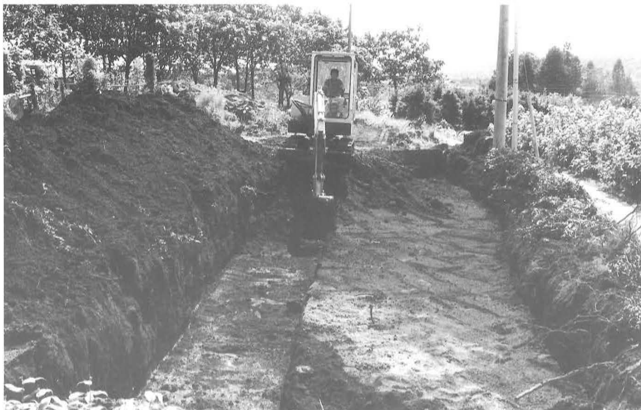
B区掘削風景（西より）
