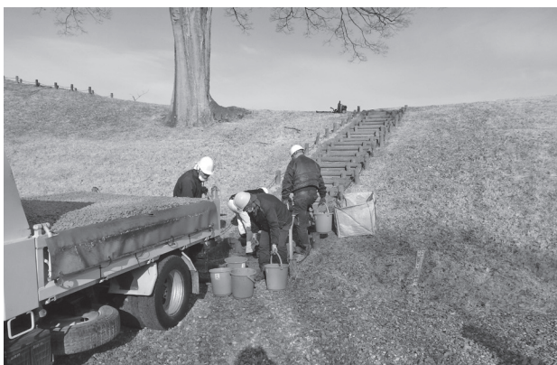
写真27 材料搬入の様子
