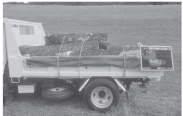
写真10 集木完了状況
