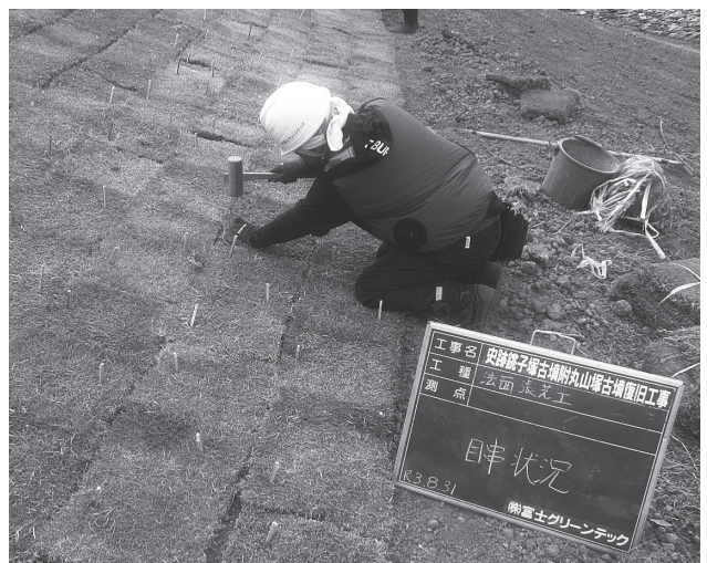
写真20 目串施工の様子
