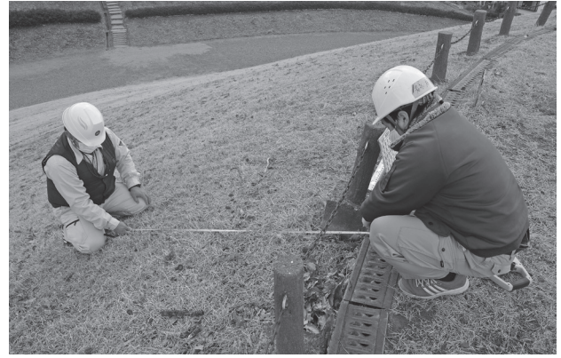
写真36 起工測量の様子
