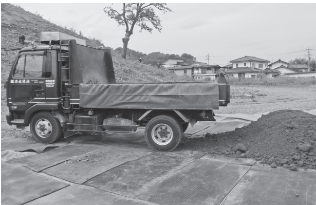
写真13 客土搬入状況
