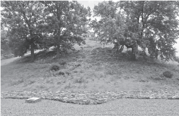
写真5 伐採・剪定工の施工前
