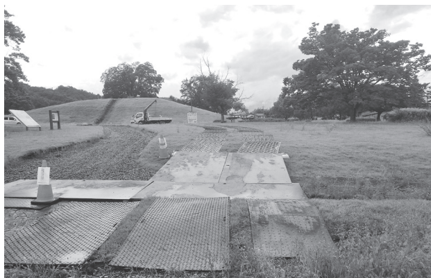
写真1 敷鉄板・プラ敷板設置状況
