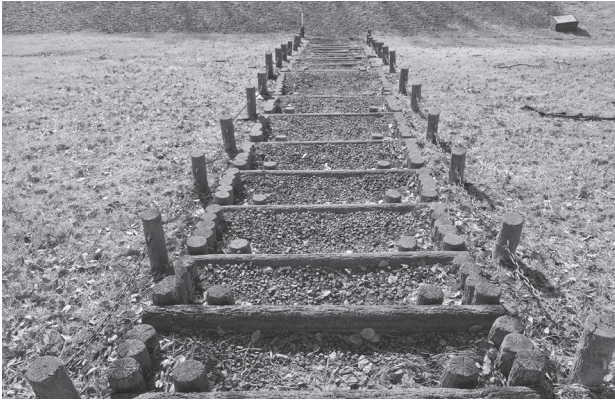
写真29 階段 No. 4 施工前
