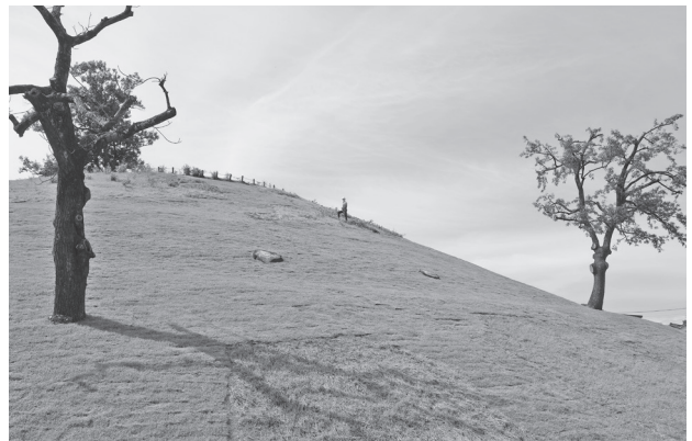
写真24 盛土復旧工事施工後
