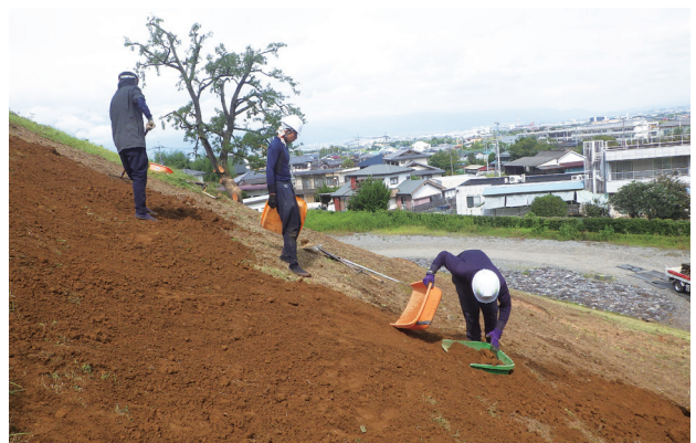
土をクレーンで墳丘の上までつり上げ、土を盛っていきます。
