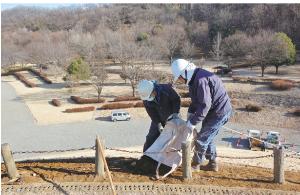
盛土工の様子。土は滑車で吊り上げて運びました。周辺の墳丘に合わせて敷きならしました。
