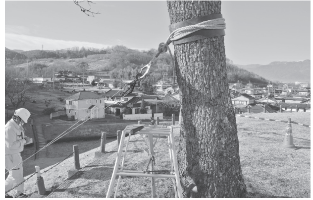
写真38 ウインチの設置状況
