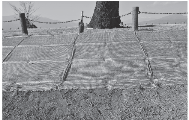
写真50 擬木柵緊急養生工事後
