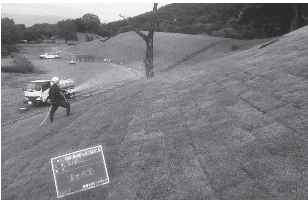
写真25 灌水養生工の様子
