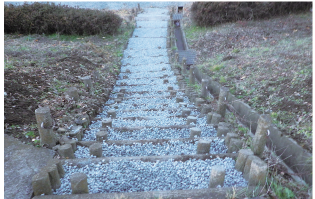
整備後の階段。歩きやすくなりました。
