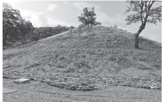
写真6 伐採・剪定工の施工後
