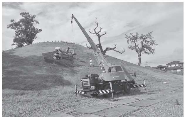
写真14 盛土工の様子
