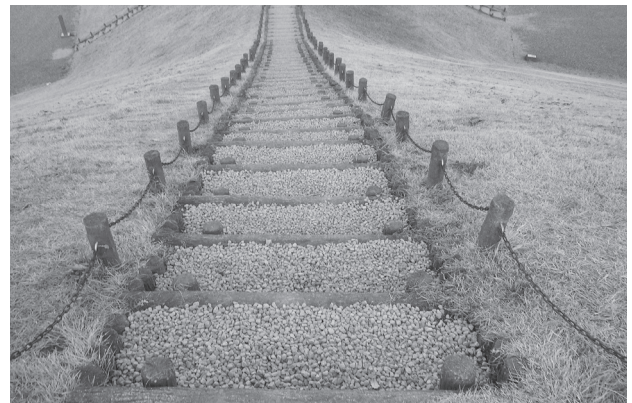
写真32 階段 No. 3 施工後
