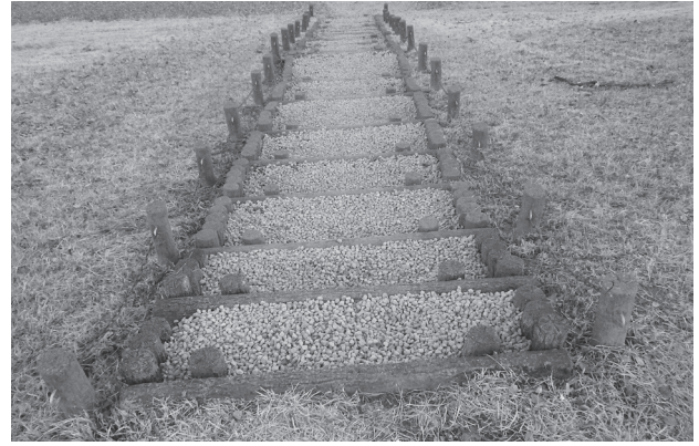
写真30 階段 No. 4 施工後
