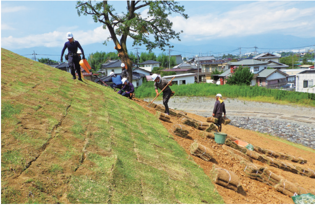
人力で芝を張り、芝が根付くように目串を打ち込み、芝の上から土をかぶせました。
