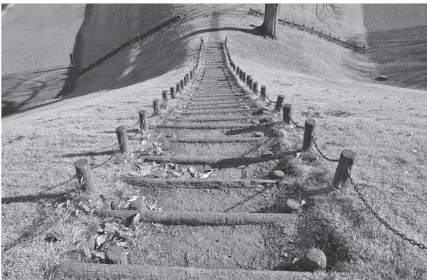
写真31 階段 No. 3 施工前
