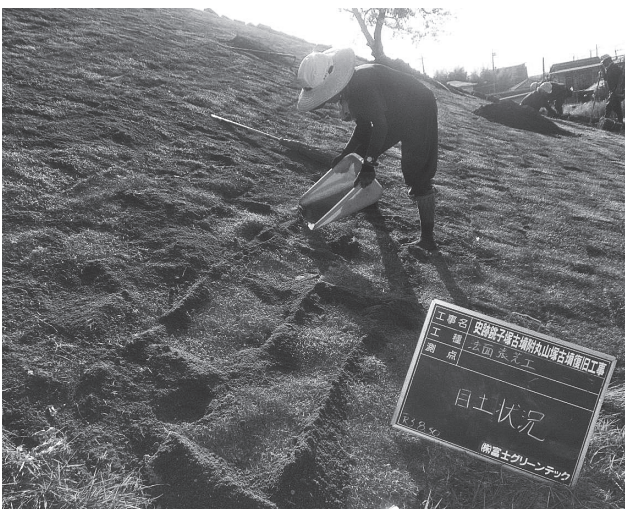
写真19 目土施工の様子
