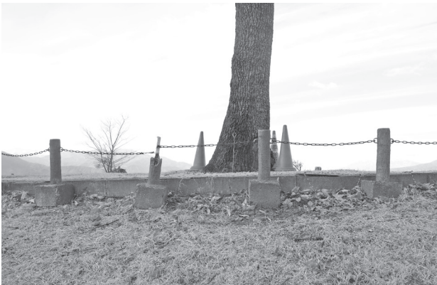
写真49 擬木柵緊急養生工事前
