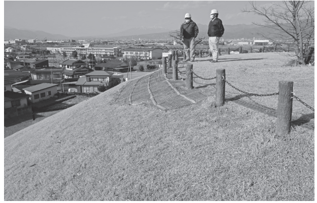
写真48 植生マット工完了2
