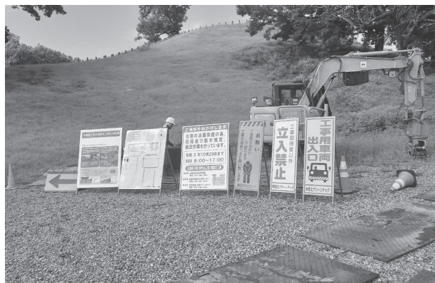
写真2 看板設置状況
