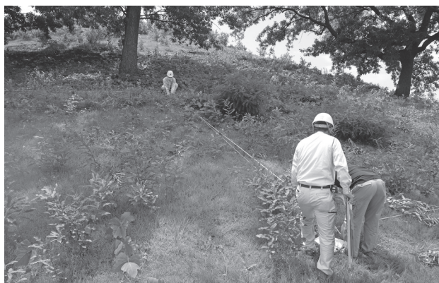
写真3 起工測量の様子
