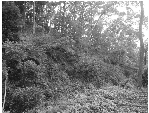
第 41 図 工事後の経過 (令和 2 年 9 月撮影) 2
