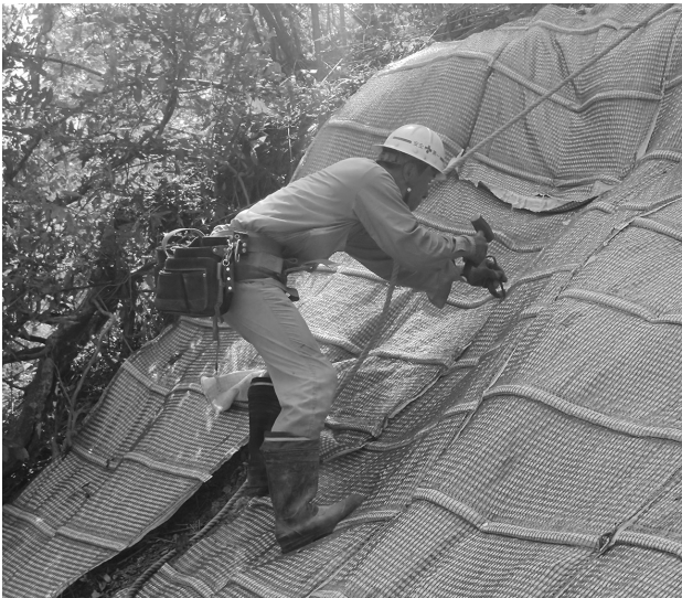
第 28 図 植生マット設置状況 2
