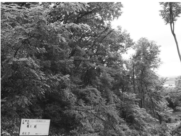
第 36 図 災害復旧工事施工前 2
