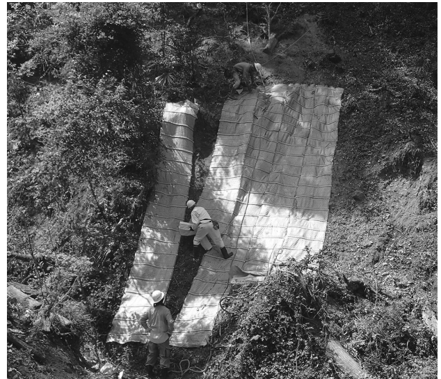
第 27 図 植生マット設置状況 1
