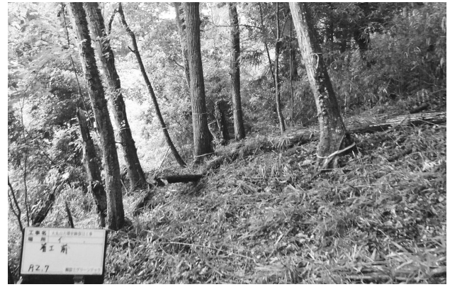
第 23 図 樹木伐採工の施工後 2
