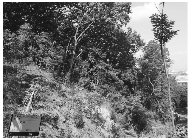
第 37 図 災害復旧工事完了後 2
