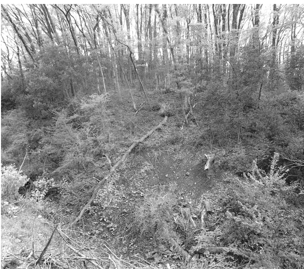
第 30 図 植生マット施工前
