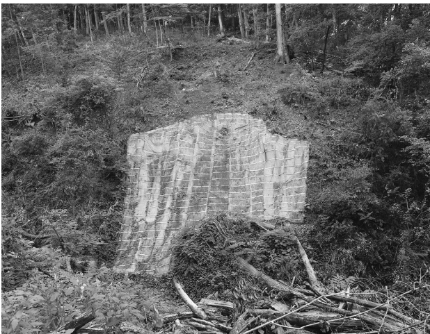
第 40 図 工事後の経過 (令和 2 年 9 月撮影) 1
