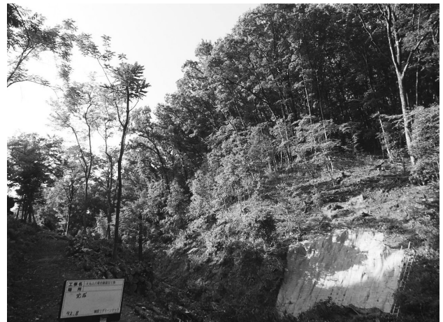
第 35 図 災害復旧工事完了後 1
