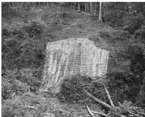
工事が終了してから約1ヶ月後の様子です。マットから芽がでてきました。
