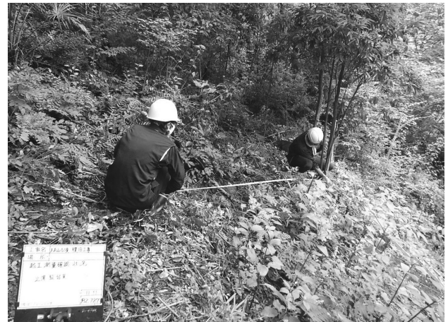
第12図 植生マット施工範囲の確認状況
