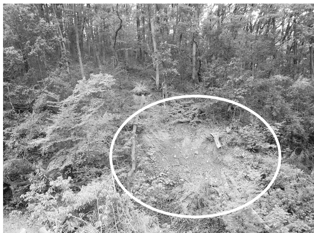
崩落箇所の拡大
