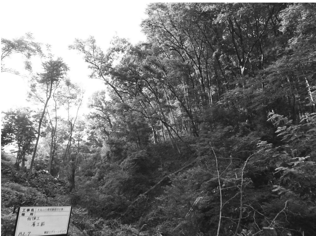
第 34 図 災害復旧工事施工前 1
