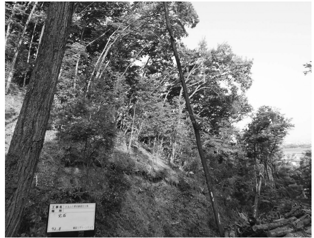
第 39 図 災害復旧工事完了後 3
