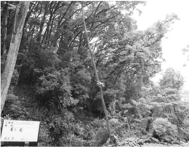
第 38 図 災害復旧工事施工前 3
