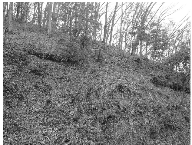
第 43 図 工事後の経過 (令和 3 年 2 月撮影) 2
