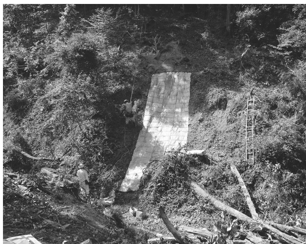
崩れた斜面がこれ以上崩れないように、植生マットをはります。
