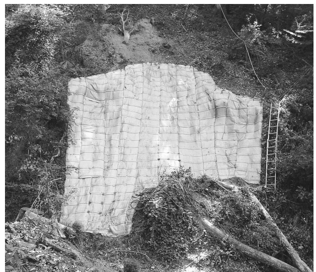
第 31 図 植生マット施工後
