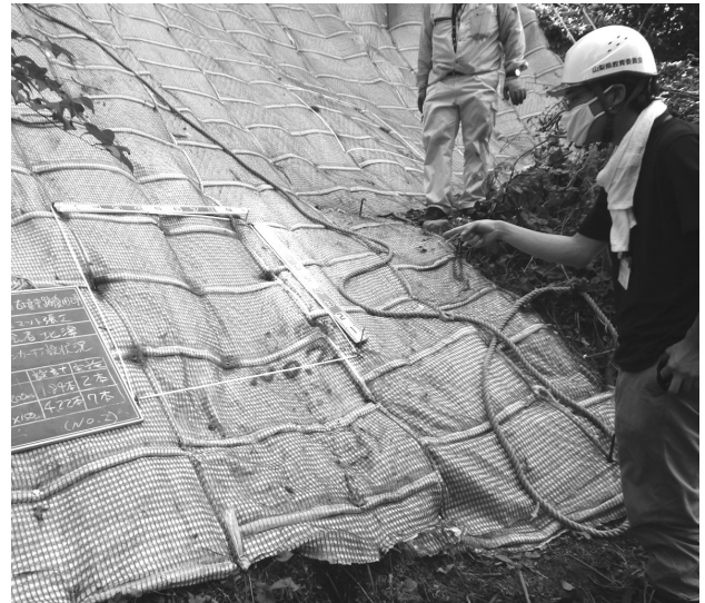
第 29 図 植生マット施工確認状況
