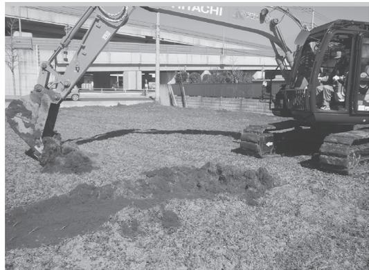
重機による表土の掘削（中央市⑩）
