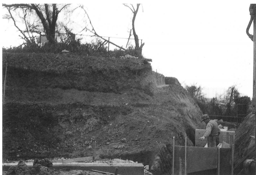
調査地(開削部付近東より)
