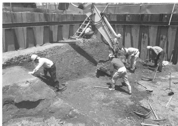
6. NR 01 掘削作業
