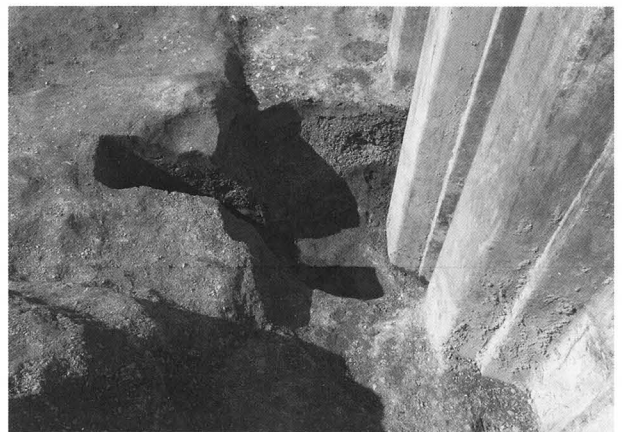
5. S E 01 掘り方完掘状況 (南から)
