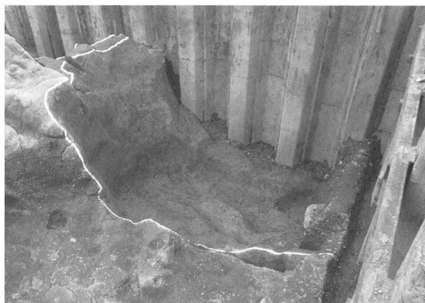
4. SK 12 完掘状況 (西から)
