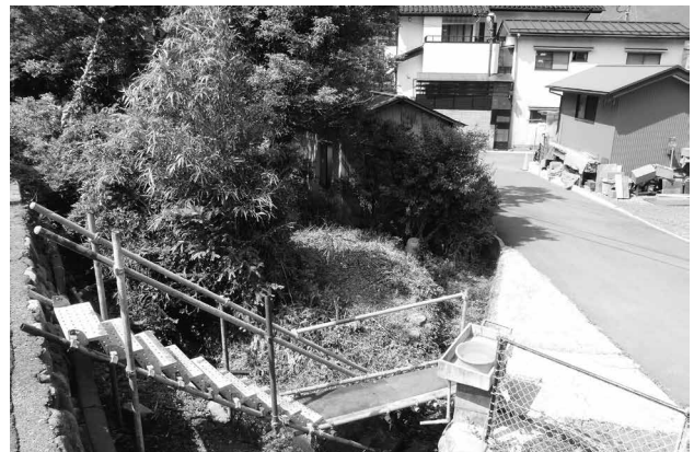
北東へ 100 mほど離れた地点に残る堤防跡
