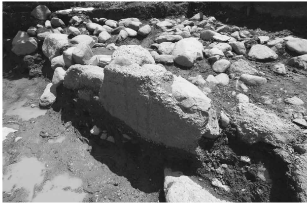
コンクリートが付着した法先部分の礫
