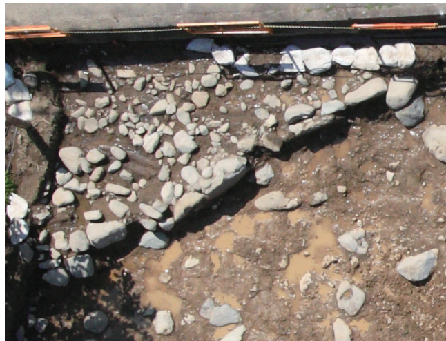
発見された堤防跡
