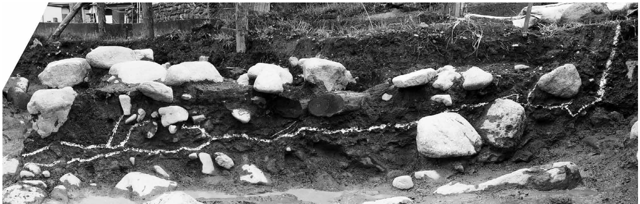
堤防断面 b-b' オルソ画像
