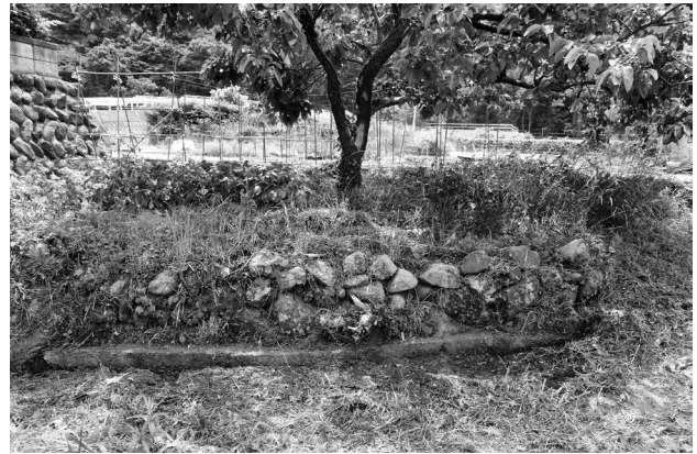
調査区東側に残る堤防跡 (川裏側から)
