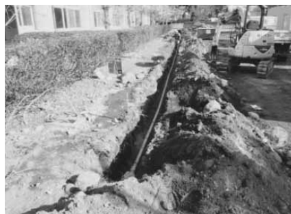
E地点掘削状況
