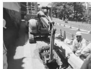
1地点 掘削状況
