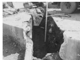
A地点 掘削状況
