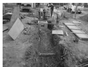
2 地点 掘削状況
