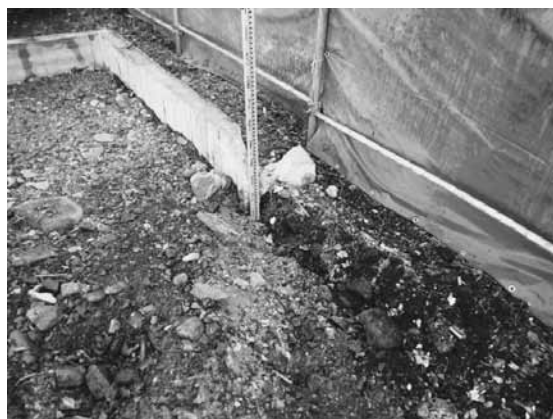
基礎撤去状況
