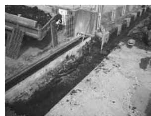
D地点 掘削状況
