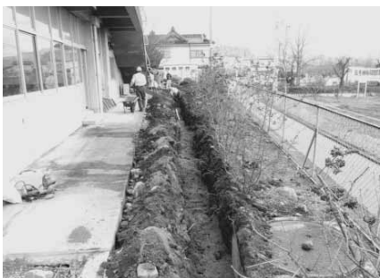
D地点掘削状況
