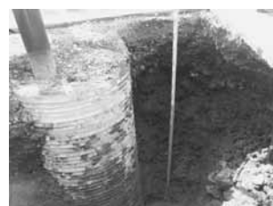
2地点 完掘状況1
