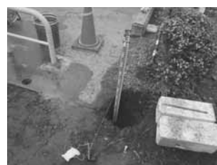
A地点 掘削状況
