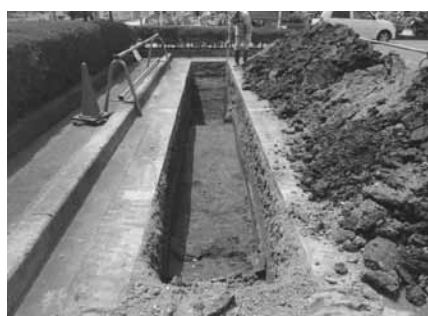
トレンチ西側完掘状況 (東から)
