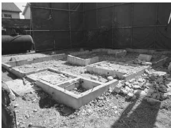
基礎撤去前の状況
