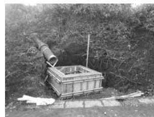
既設枡(外)改修状況
