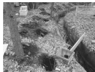
C地点 掘削状況
