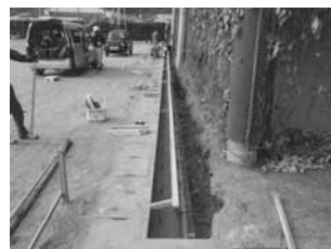
第1地点 掘削状況
