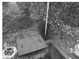
量水器2地点 掘削状況
