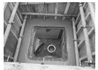
既設枡(内)改修状況
