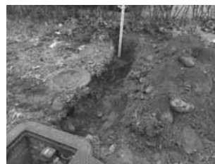
量水器1地点 掘削状況
