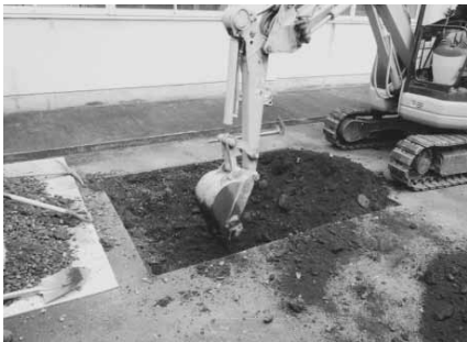
A地点掘削状況
