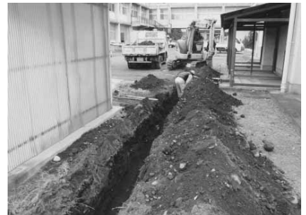
C地点掘削状況
