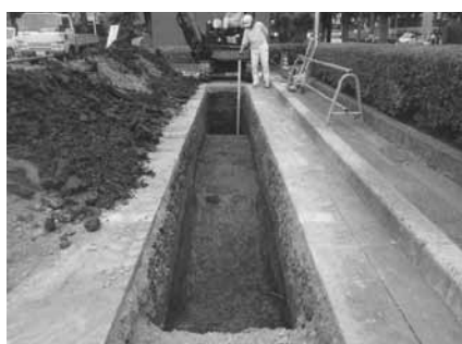
トレンチ東側完掘状況 (西から)
