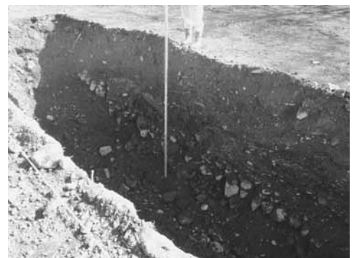
3号トレンチ石積み検出状況
