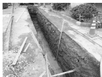
西側～中央掘削状況
