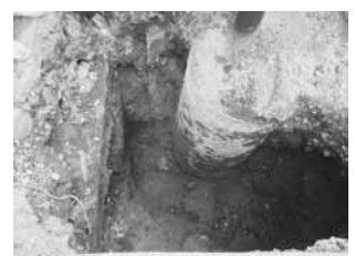
2地点 完掘状況2
