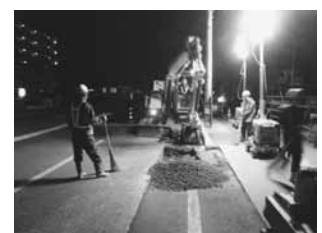
2地点 掘削作業状況
