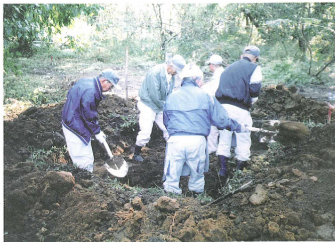
轟木地区作業風景
