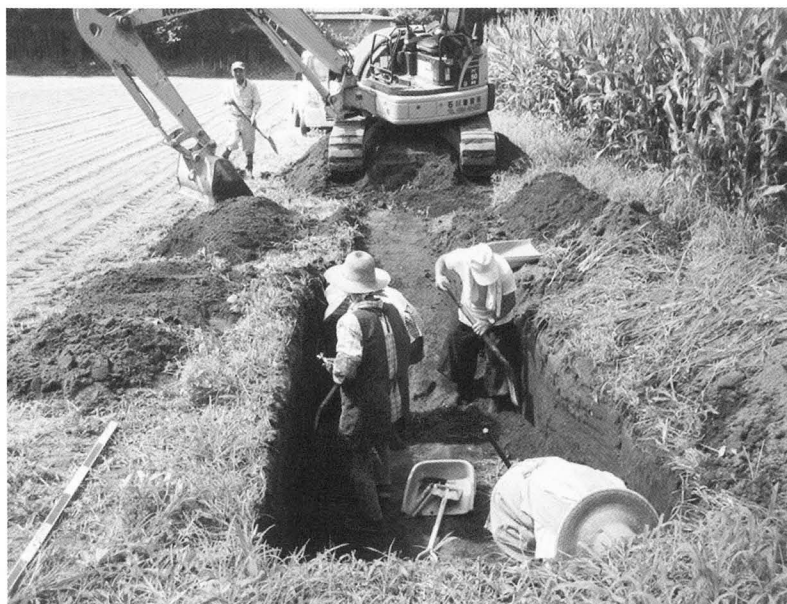
写真3 トレンチ精査状況
