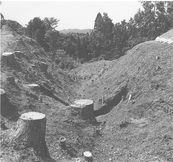
③ 柵屋遺跡道状遺構-2 (東側から)
