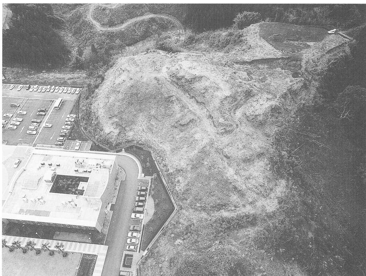
G区全景（北上空から）
