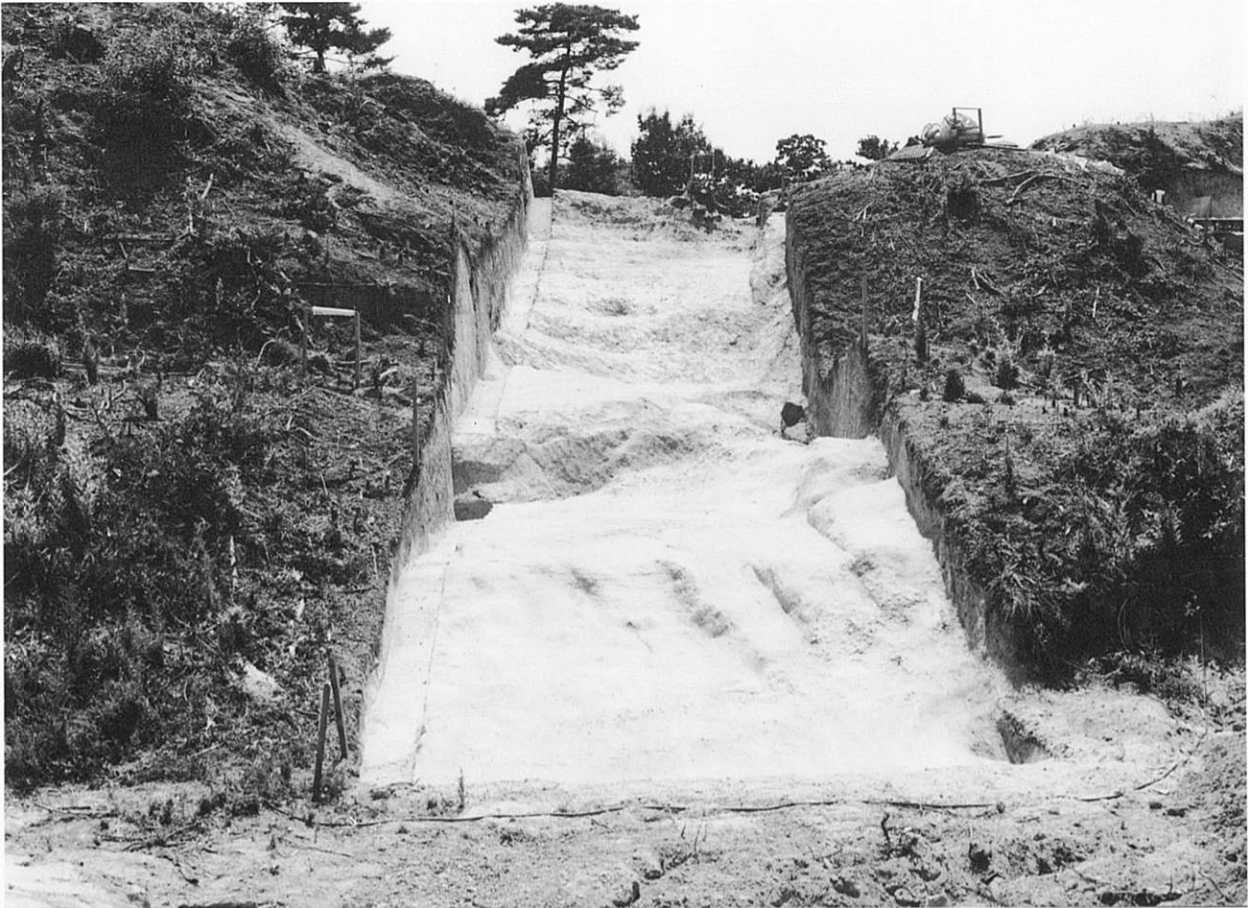
第3調査区 (北西から)
