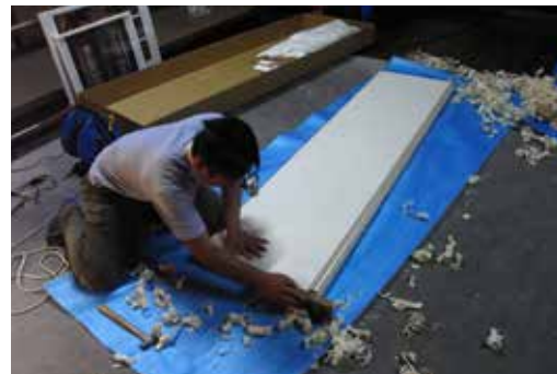
図16 建て合せ（現地にて微調整）
