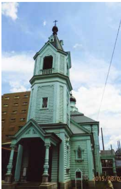
写真1 修理前外観(2015年8月)
