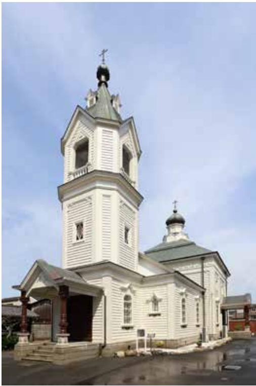
写真3 塗装修理後外観（2018年1月）
