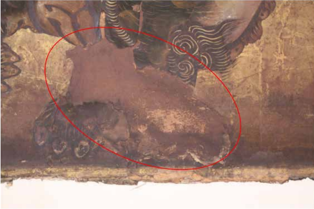
写25 修理前 東側
