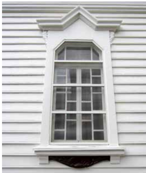
写真7 1階窓框下裝飾塗装（修理後）→
