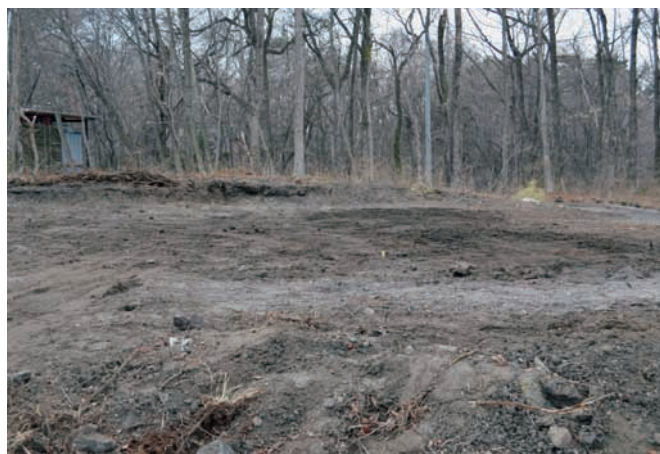
5. 埋め戻し状況（東から）
