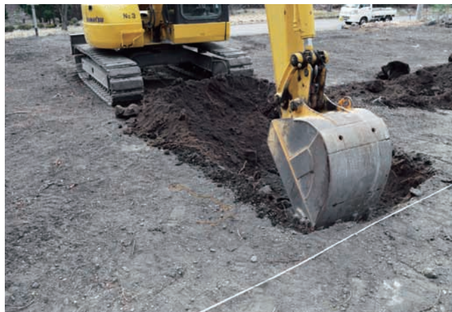
3. 掘削状況（北西から）
