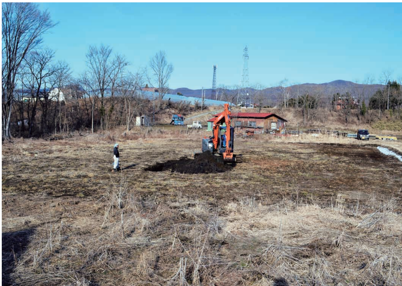
5. 第2調査地点全景 (西から)
