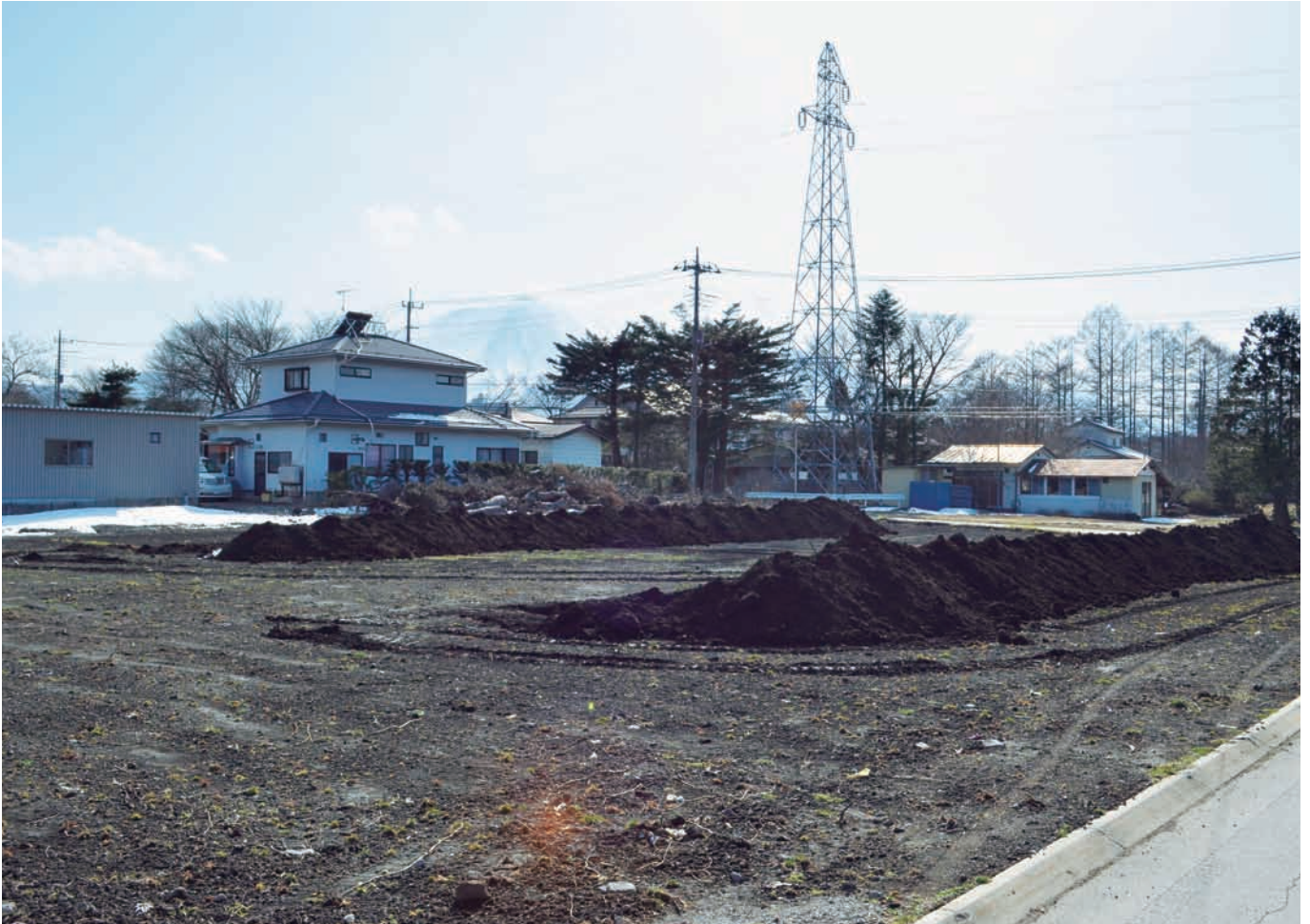
1. 第1調査地点（北東から）
