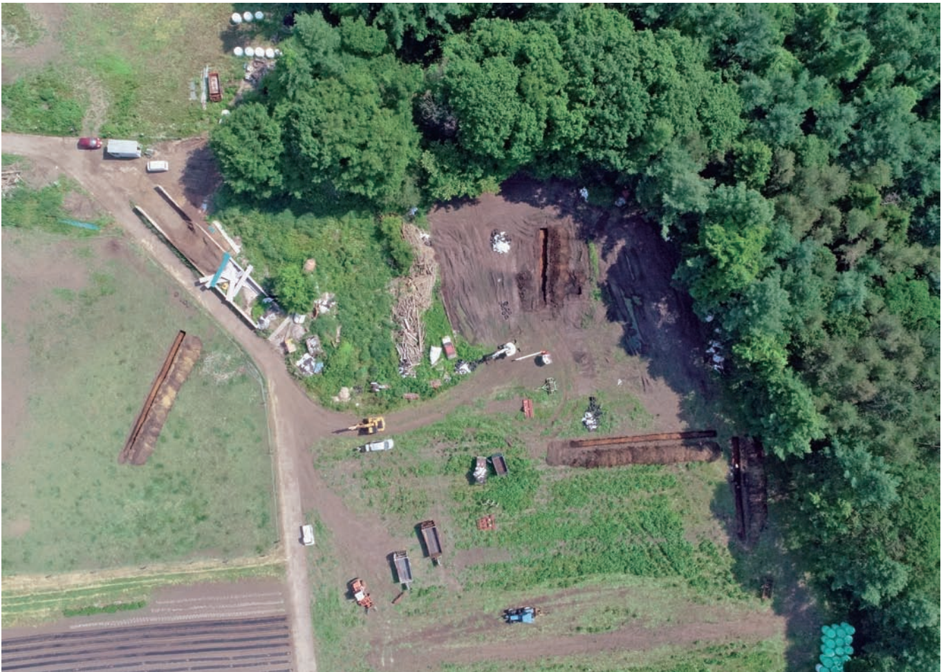
3. 応桑字小菅 調査区全景（北上から）
