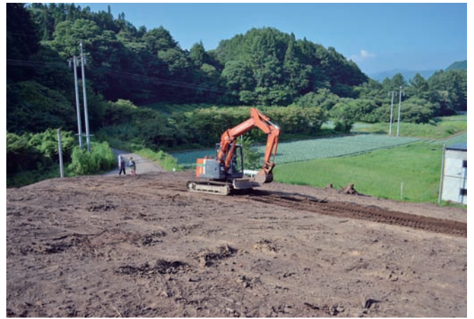
2. 埋め戻し状況 (南から)
