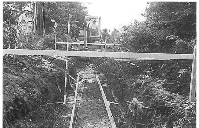
P L. 19 掘削風景
