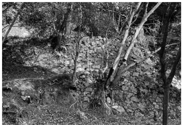
写真3 金龍寺方丈西側法面石垣
