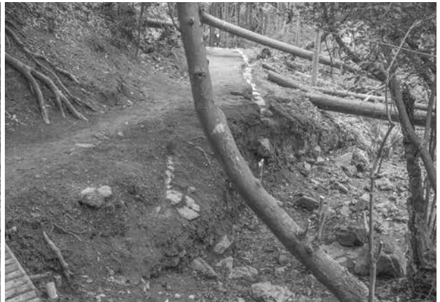
6. 十丁石以南参道検出状況② (北東から)
