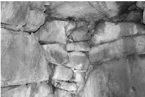
写真 11 奥壁と右側壁の持ち送り
