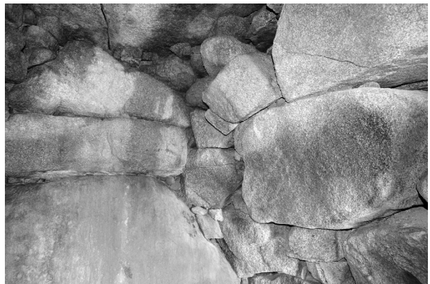
写真 12 奥壁と左側壁の持ち送り
