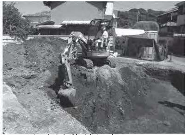
2. II区 表土掘削 (東から)
