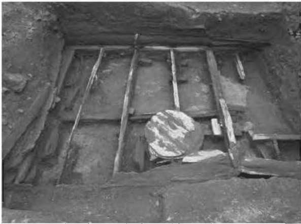
2. I区下層 建物 2A 根太材 (東から)
