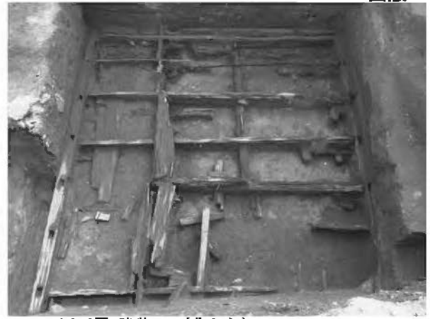
5. I区下層 建物 2A (北から)
