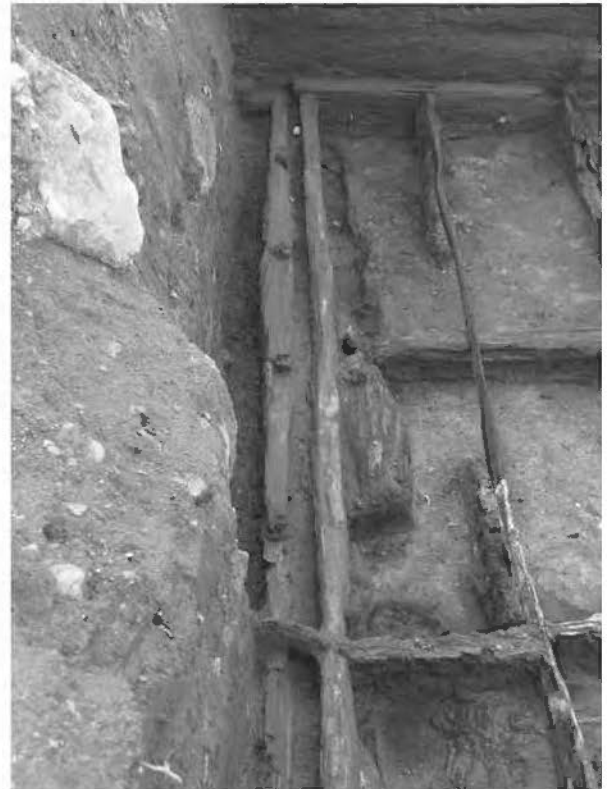
6. I区下層 建物 2A 南辺土土台材 (東から)
