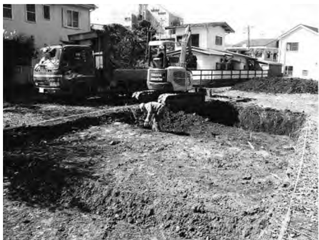
1. 地点Ⅱ 表土掘削作業（北東から）
