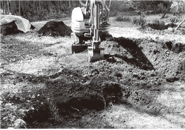
△1. 重機による表土掘削風景
