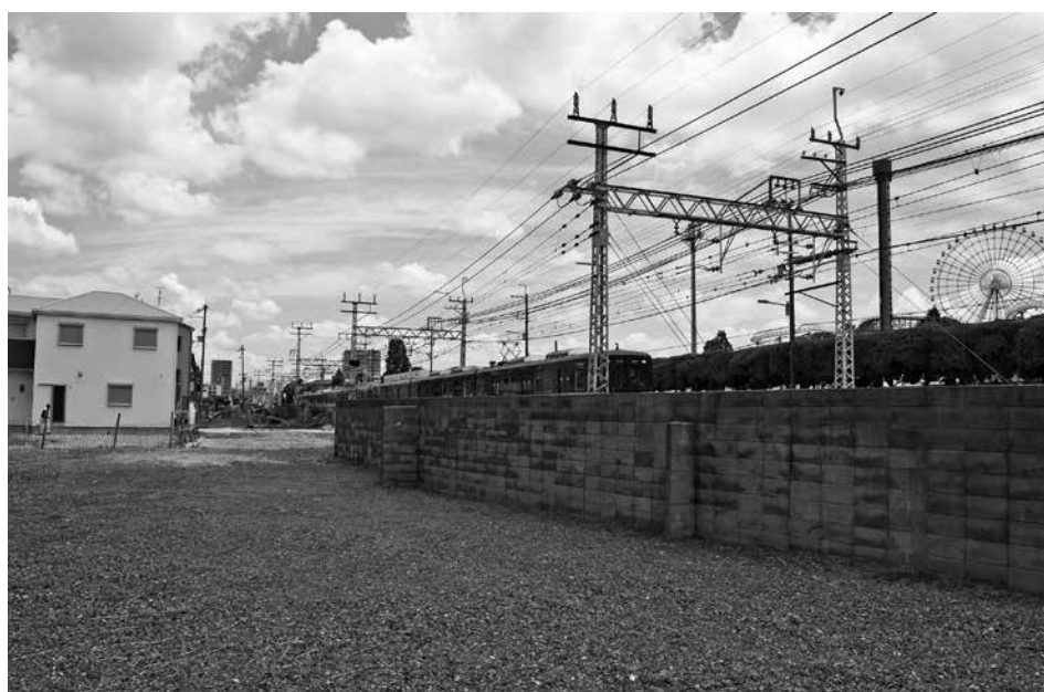
3. 5・6区 調査区 調査前遠景 (南西から)
