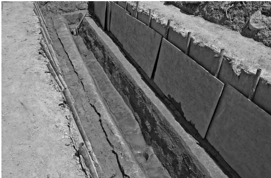
3. 第5-1層下面 南側 全景 (南西から)
