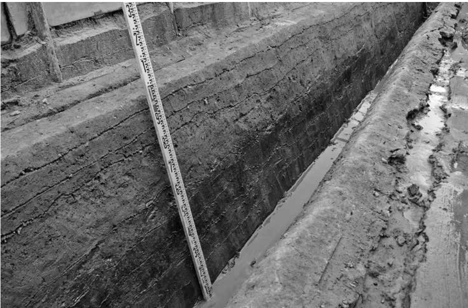
3. 東壁 南側 地層断面 (北西から)
