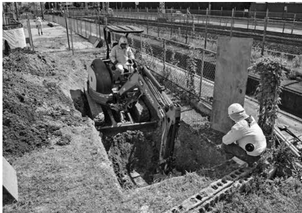
5. 4区 作業風景 (南西から)
