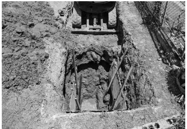
6. 4区 最終掘削状況 (南西から)
