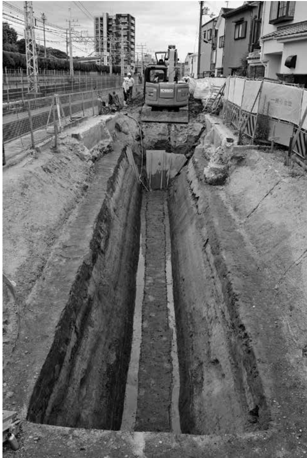
1. 第6-2層下面 北側 全景 (北東から)
