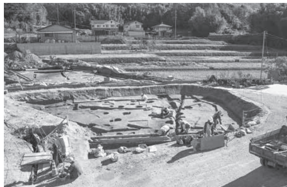
写真9 掘立柱建物9調査状況（西から）
