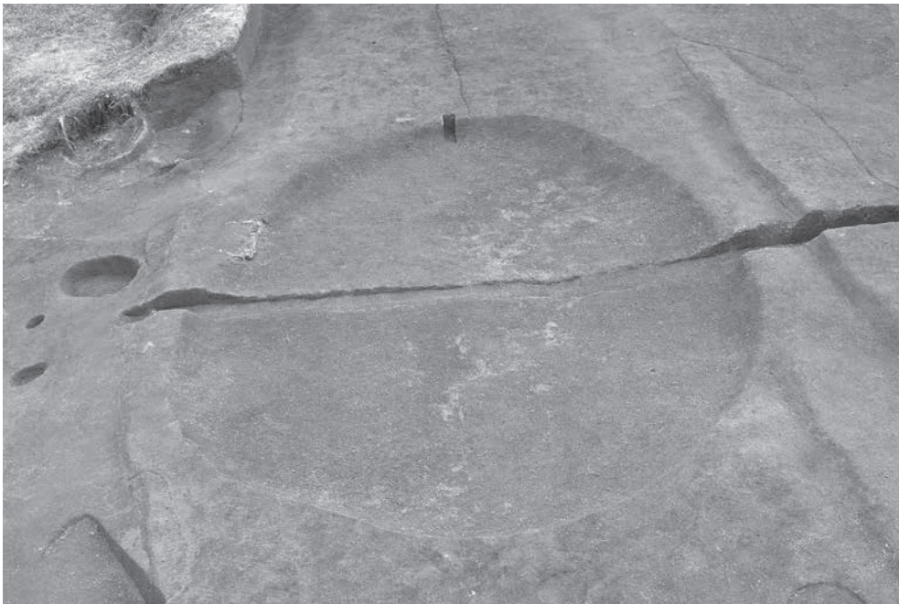
2 たわみ6 (北西から)
