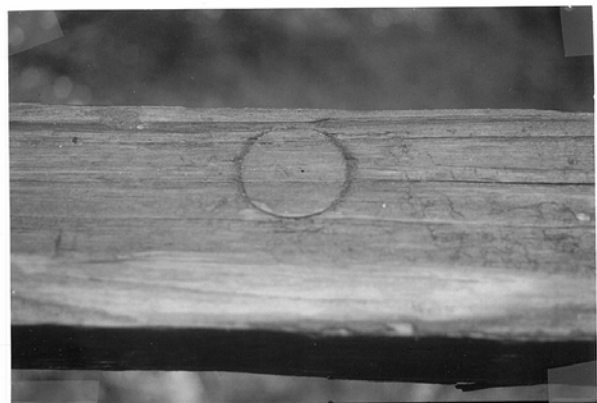
6. 側溝出土の地覆材
