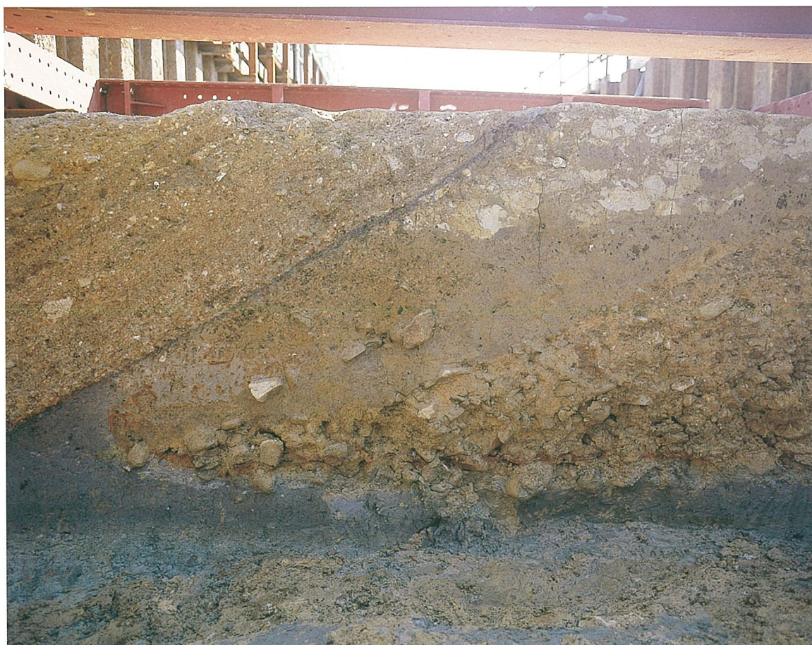
D-1地区（上町東遺跡）線路盛土断面
