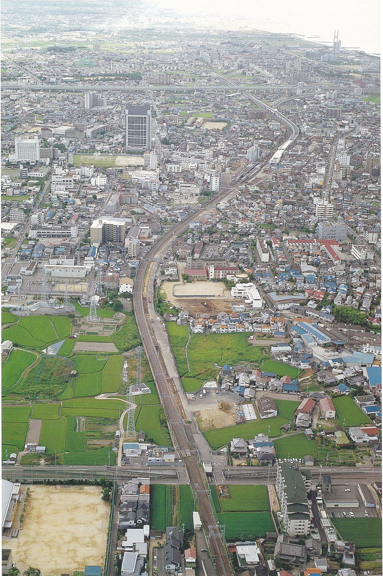
調査区遠景（北東から）
