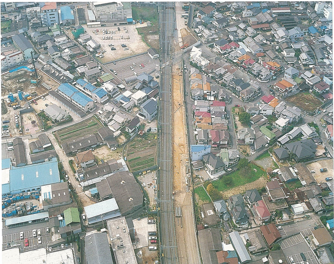
F地区（上町東遺跡）全景（東から）
