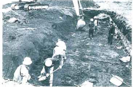
写真4. 表土掘削風景
