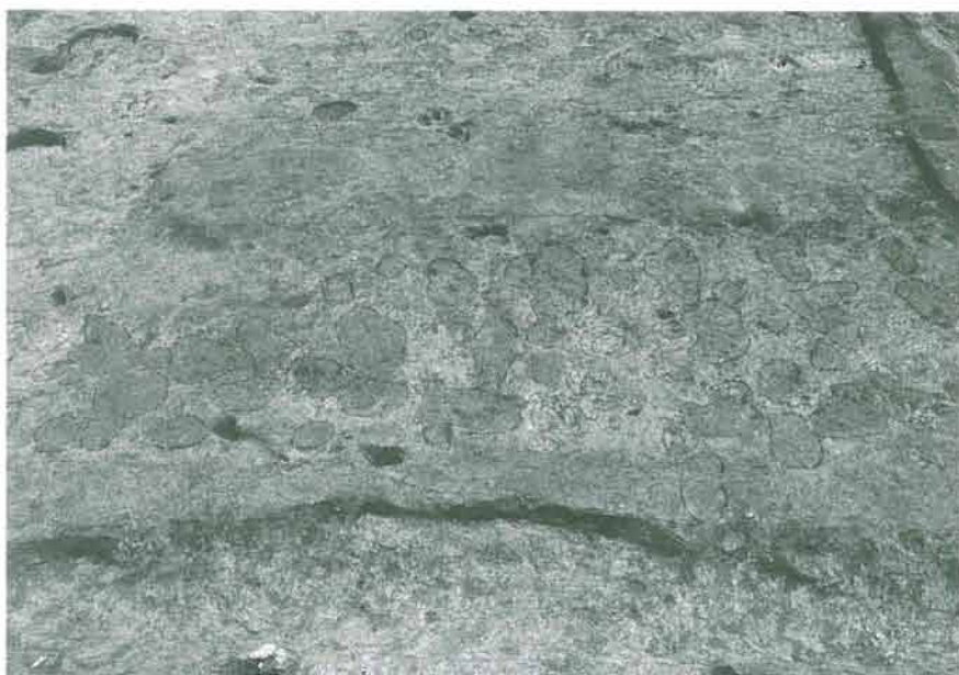
2. SF-1 南側硬化面 検出近景(西から)
