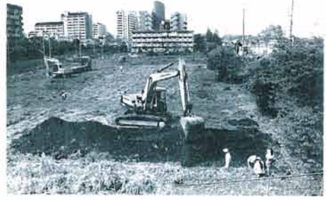
写真3. 表土掘削開始
