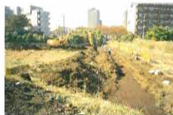
▲ 表土掘削開始
