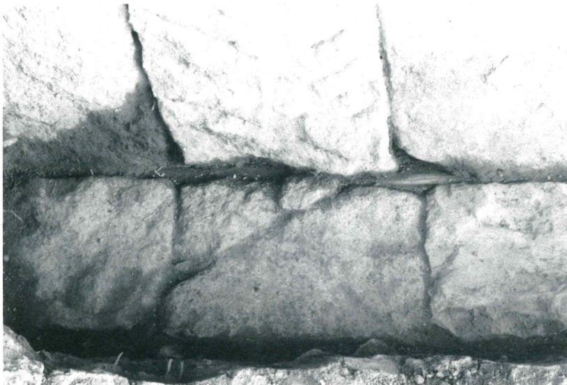
石垣1 石垣下の胴木の状況 (西から)
