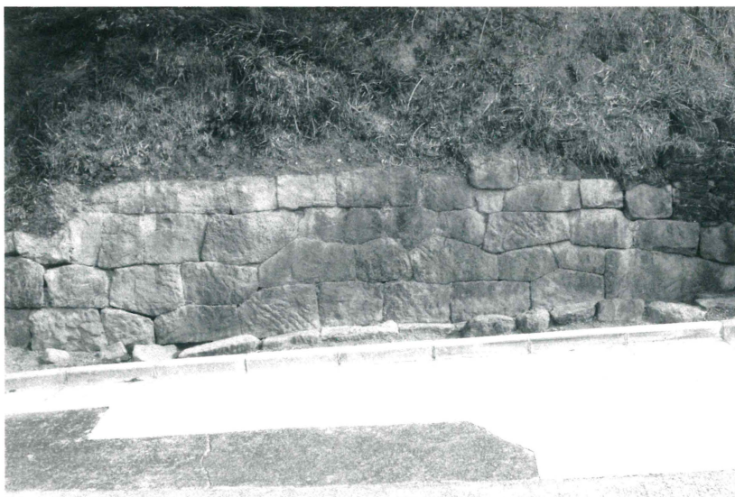
石垣2 全景 (西から)
