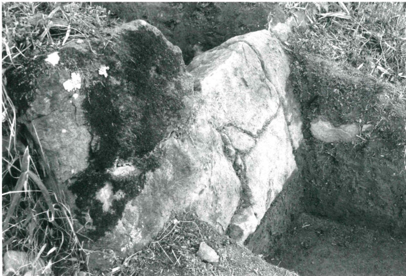
石垣4 石垣の状況 (北から)
