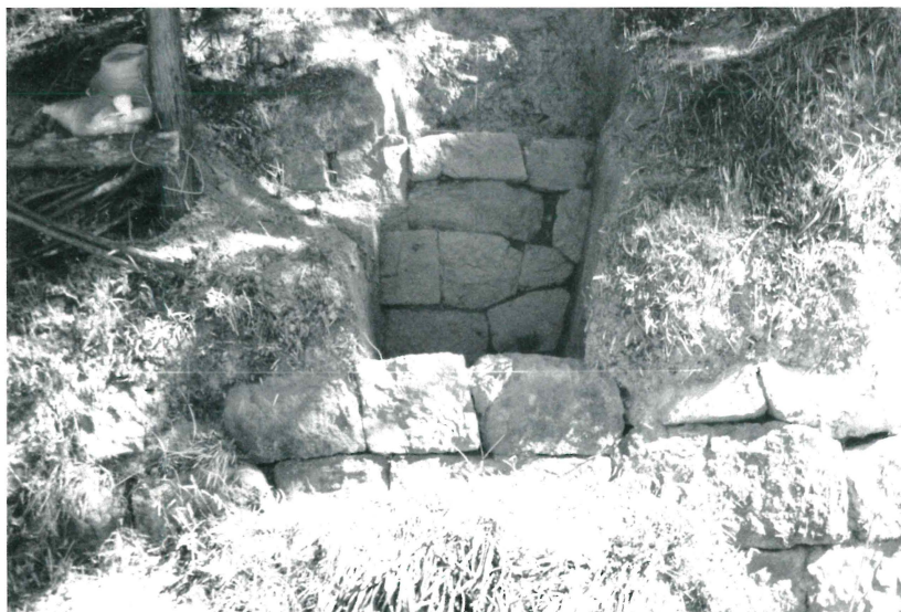
石垣3 石垣の状況 (西から)
