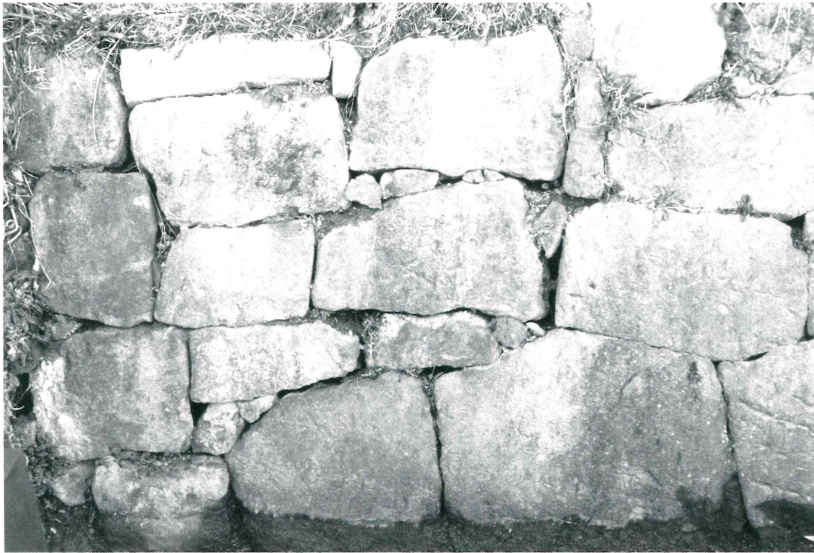
石垣1 北端部分の状況 (西から)
