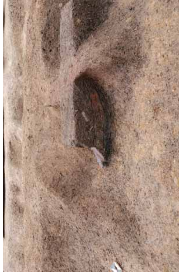
7区 SH04 竈断面 南から
