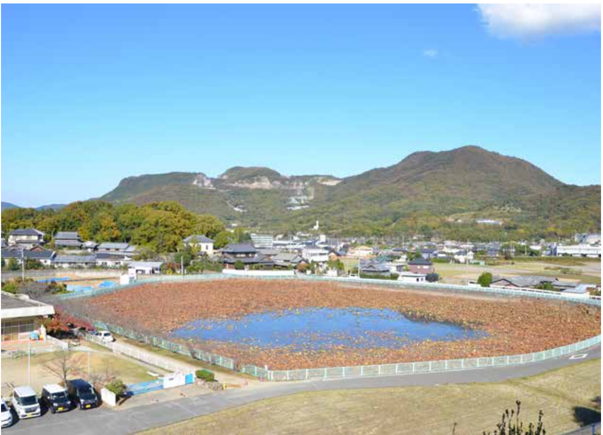
2. 36 - 1 ~ 3区 遠景 (南から)
