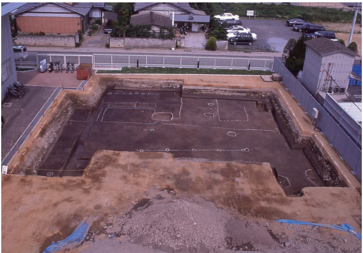
Ⅳ区 全景(西から)
