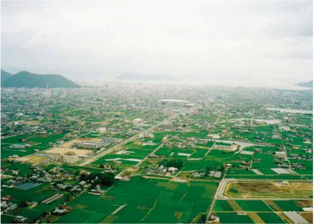
写真1 遺構上空から北を望む（平成9年7月17日撮影）
