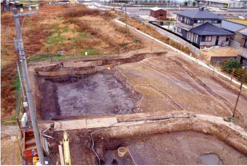
写真 54 SR06・07 掘削状況 (東から)
