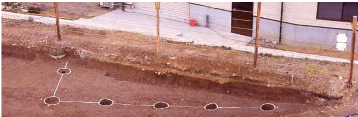
写真 19 SB2301 全景 (南から)
