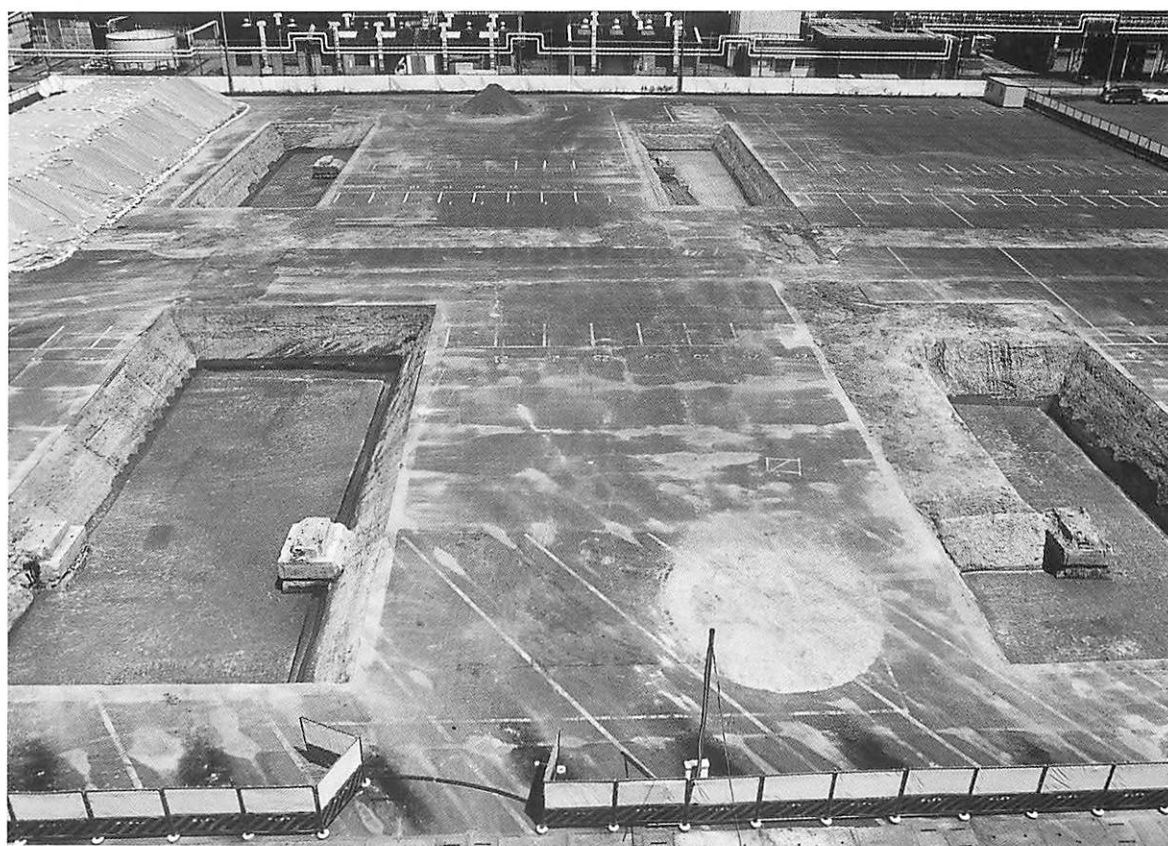
終了全景（西・6層駐車場屋上東より）
