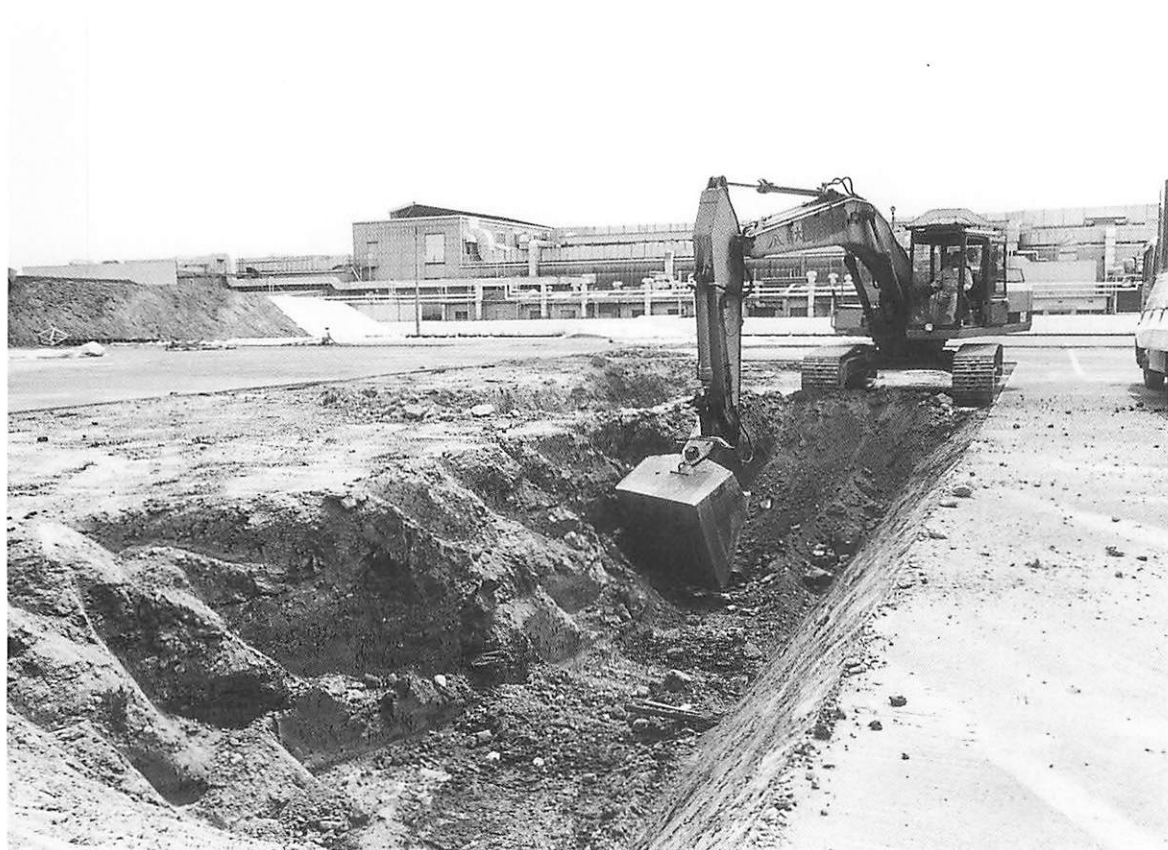
機械掘削光景（西より）
