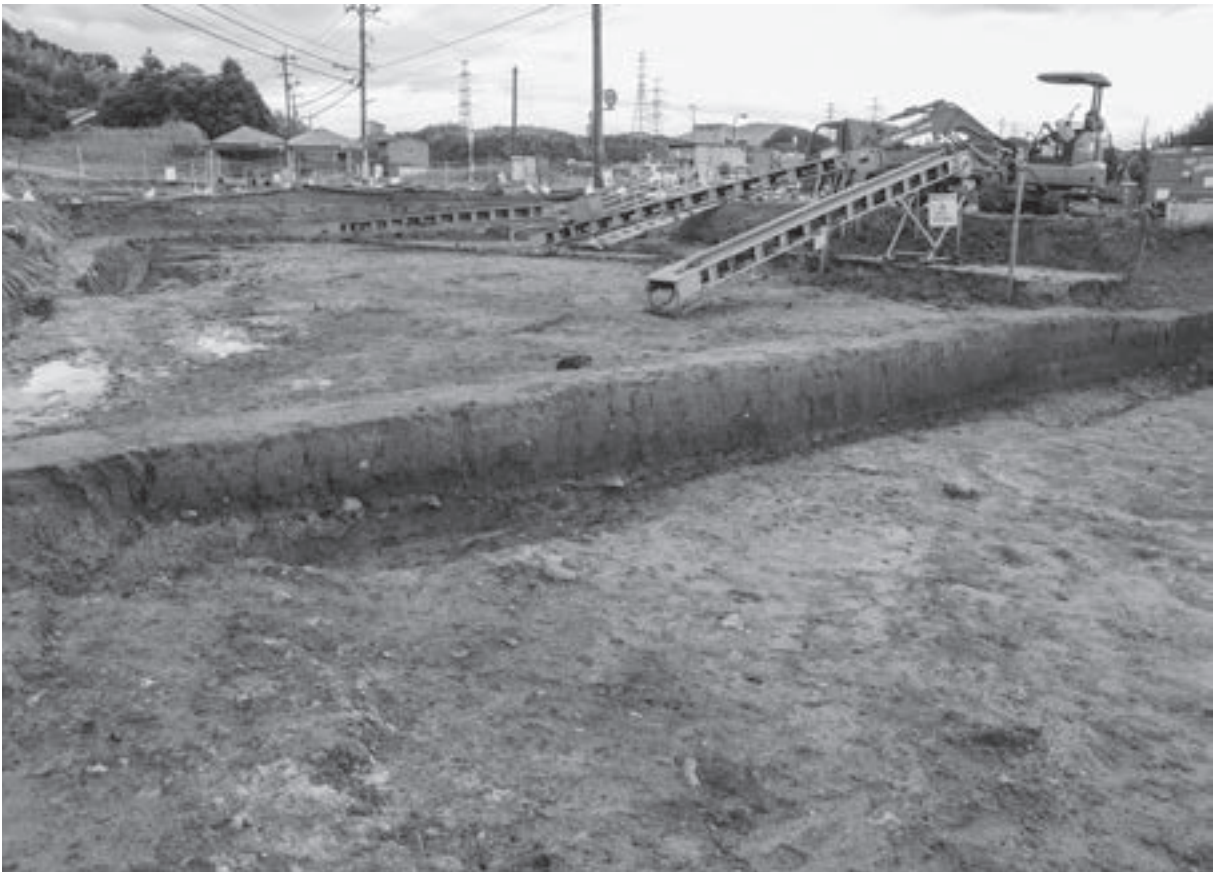
2. D区 中央ベルト土層堆積状況 (西から)
