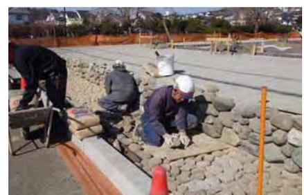
写真 34 雨落ち石敷きの施工
