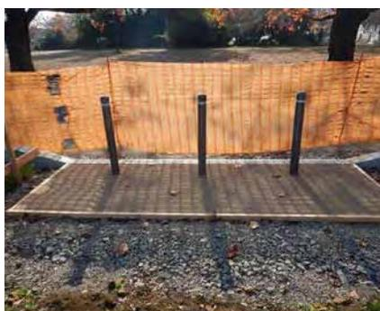
出入口の透水性まき土舗装と車止め
