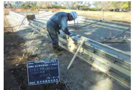
㉔須弥壇 コンクリート擁壁打設
