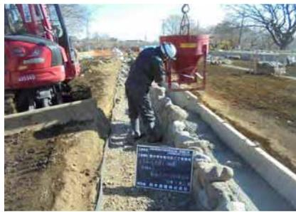
⑧基壇外装 裏込めコンクリート打設
