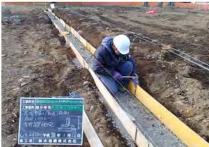
④基礎外装 基礎コンクリート型枠設置
