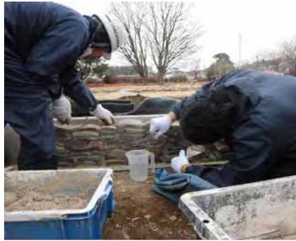
①擬土を用いた瓦積作業
