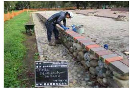
㉑基壇上面 基壇端部磚目地詰め
