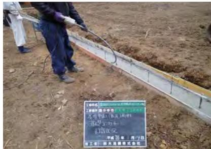
⑤基礎外装 基礎コンクリート打設
