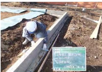
⑦基礎外装水 抜きパイプ設置
