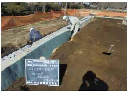
⑩基壇外装 吸出し防止材布設置
