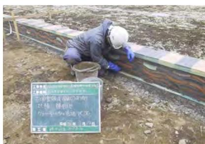
⑪基礎外装 瓦積み目地モルタル充填
