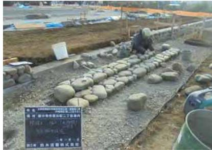
⑤⑩基壇北側階段 玉石据付け
