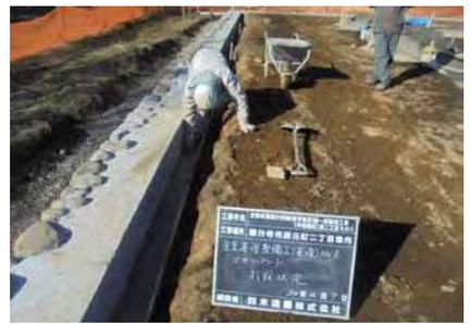
⑨基壇外装 止水コンクリート打設
