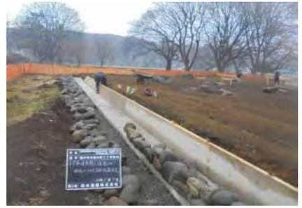
⑥基壇外装 胴込コンクリート型枠設置
