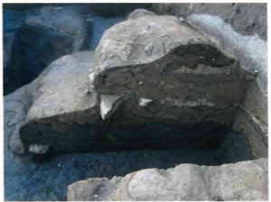
▲中枢部区画施設北西地区 築地塀基礎部分の断割り状況 基底部分は黒色土で、その上に粘質の褐色土と白色粘土・砂質土を、固く叩き締めながら積み上げている状況が判ります。
