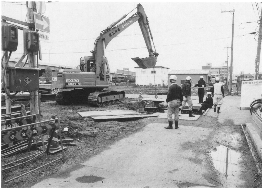
調査風景 (北より)
