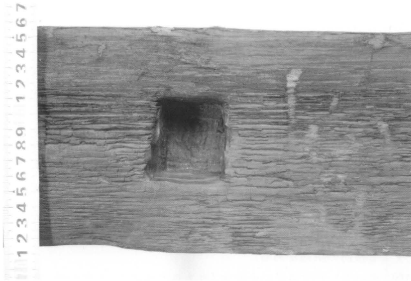
図133 井戸202隅柱. 棧の取り付くほぞ穴のある面(上)とない面(下).
